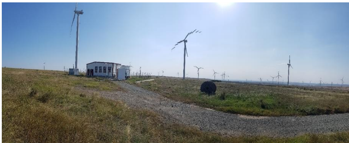
Fig. nr. 9 Vedere generala - Statia Electrica de conexiuni
