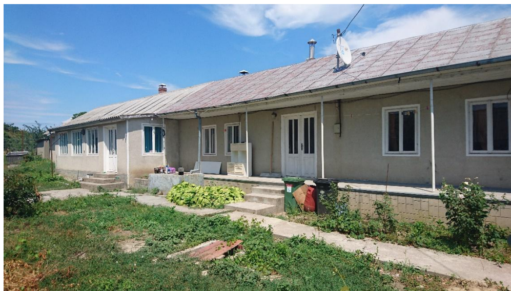
Fig. 2 – imagine constructii existente pe amplasament
