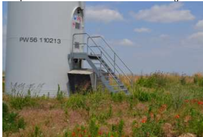
Fig. 5 - Platforma turbina innierbata
