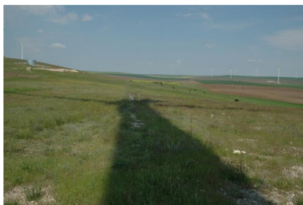
Fig.7 – traseu cabluri electrice innierbat dupa trei sezoane de vegetatie
