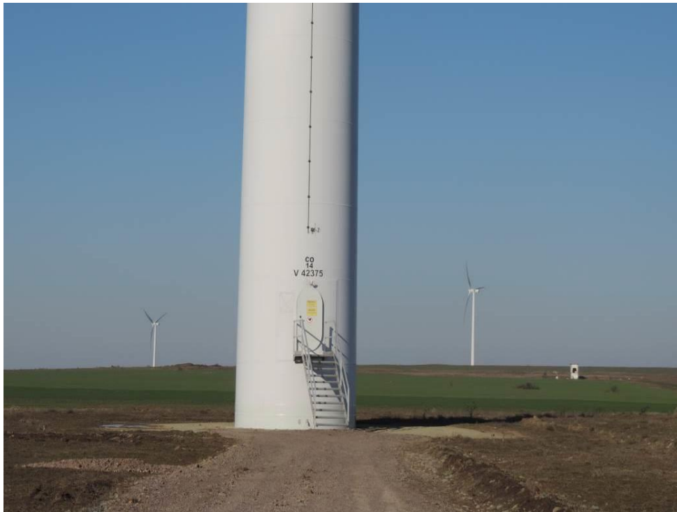
Foto 9 Aspect din amplasament reprezentand suprafete decoperate/recoperate din proximitatea turbinelor (martie 2014)
