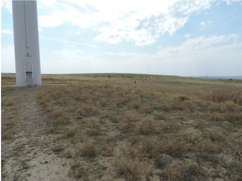
Foto 72 Aspect al vegetației instalate pe platformele tehnologice a turbinei eoliene CO_03 (august 2014)
