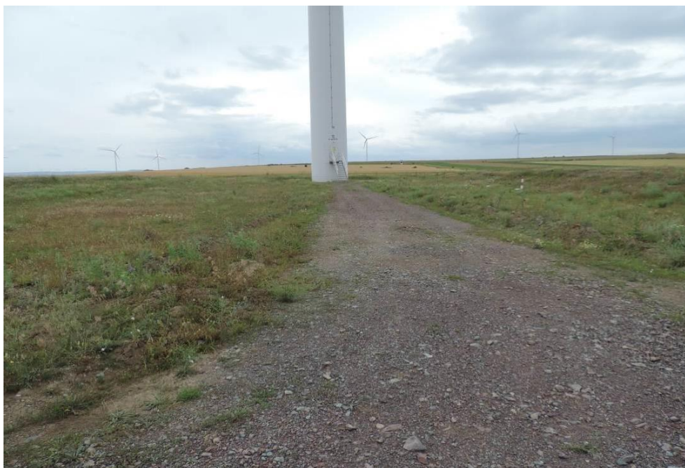
Foto 52 Aspect al vegetației instalate pe platforma tehnologică a turbinei CO_14 și la marginea drumului de acces către aceasta (iunie 2014)
