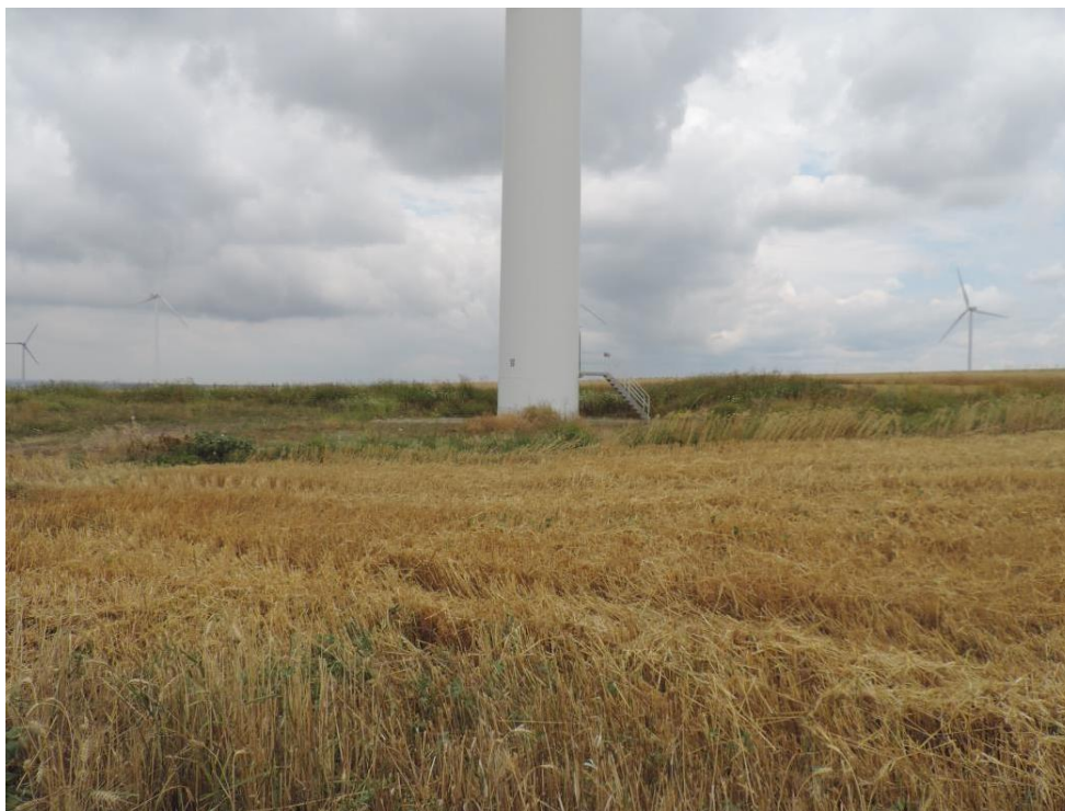
Foto 60 Aspect al vegetației instalate pe platforma tehnologică a turbinei CO_29 (în proximitate, culturi de cereale) (iulie 2014)
