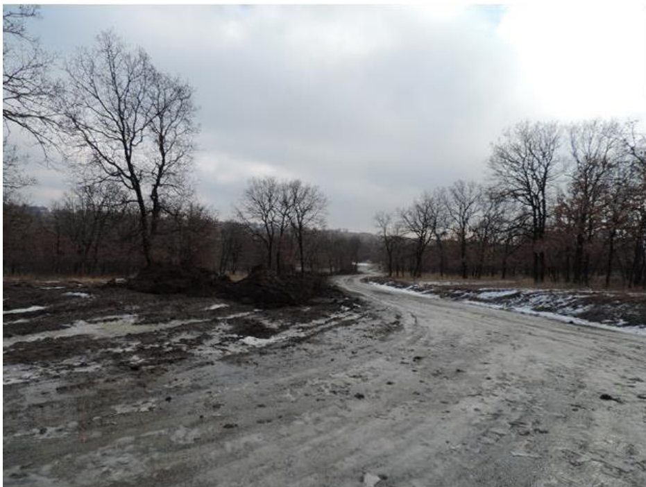
Foto 168 Drum de acces nou construit, ce porneste din drumul principal de la marginea padurii de stejar, catre turbinele parcului eolian invecinat. Se observa fragmentarea habitatului de padure de stejar pufos si depozitarea neadecvata a pamantului excavat care exercita presiune asupra vegetatiei lemnoase
