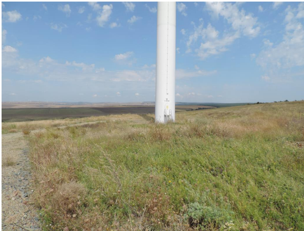
Foto 76 Aspect al vegetației instalate pe platforma tehnologică a turbinei eoliene CO_36. (august 2014)
