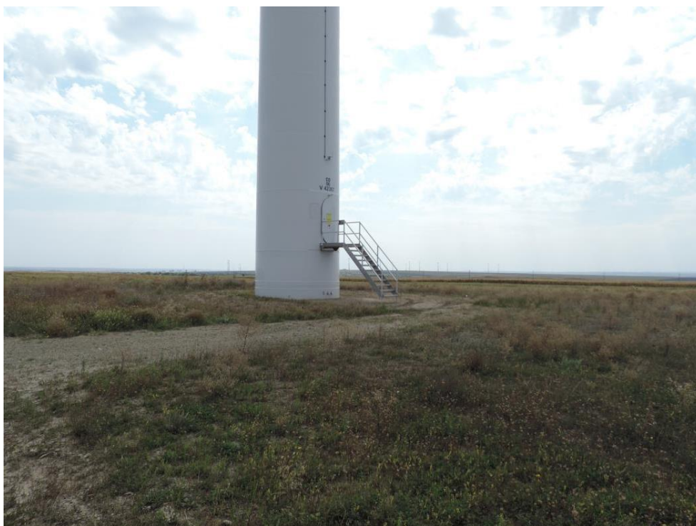
Foto 71 Aspect al vegetației instalate pe platforma tehnologică a turbinei CO_06 (august 2014)
