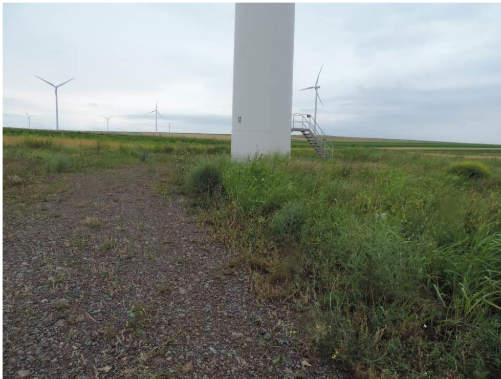
Foto 51 Aspect al vegetației instalate pe platforma tehnologică a turbinei CO_09 (iunie 2014)
