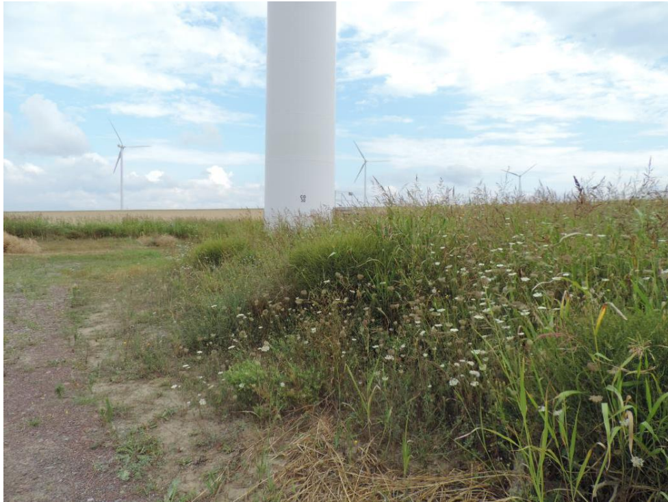
Foto 61 Aspect al vegetației instalate pe platforma tehnologică a turbinei CO_30 (iulie 2014)
