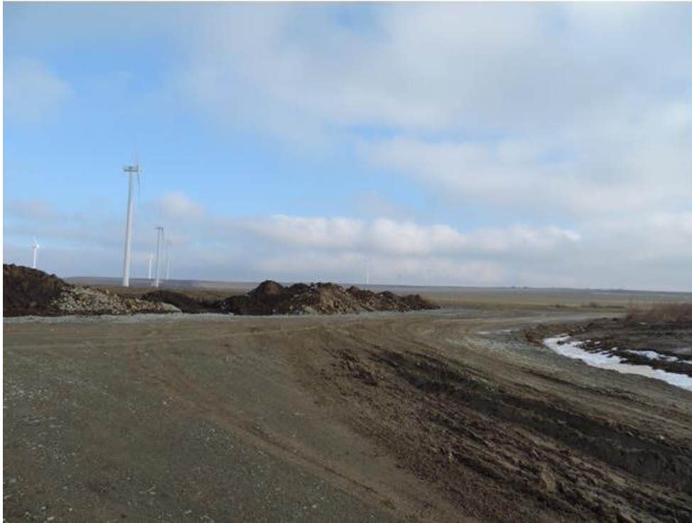
Foto 166 Latirea drumului si depozitarea pamantului excavat in strat inalt la marginea drumului de acces la turbinele CO_27, CO_28, din amplasamentul parcului eolian Corugea
