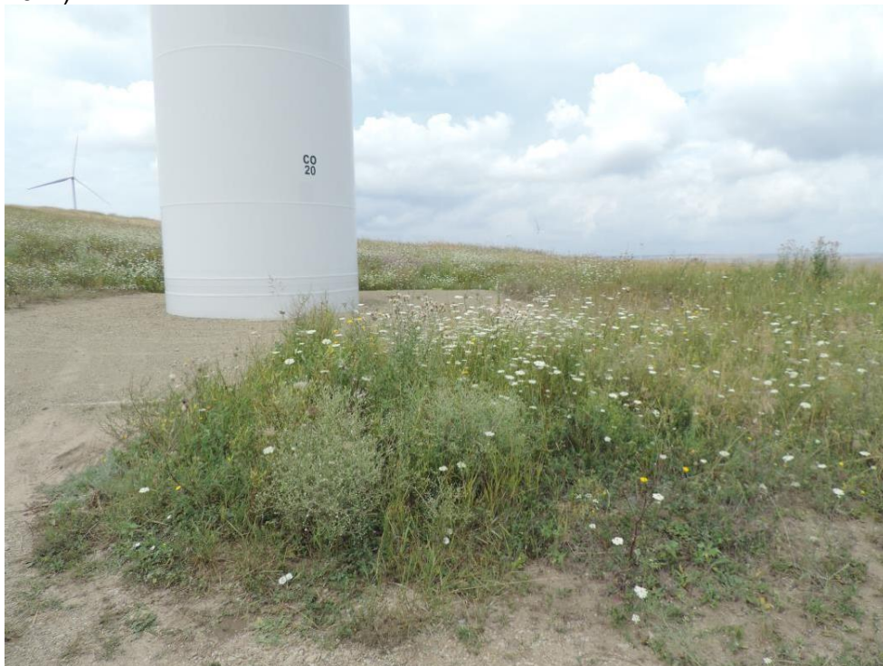
Foto 62 Aspect al vegetației instalate pe platforma tehnologică a turbinei CO_20. (iulie 2014)
