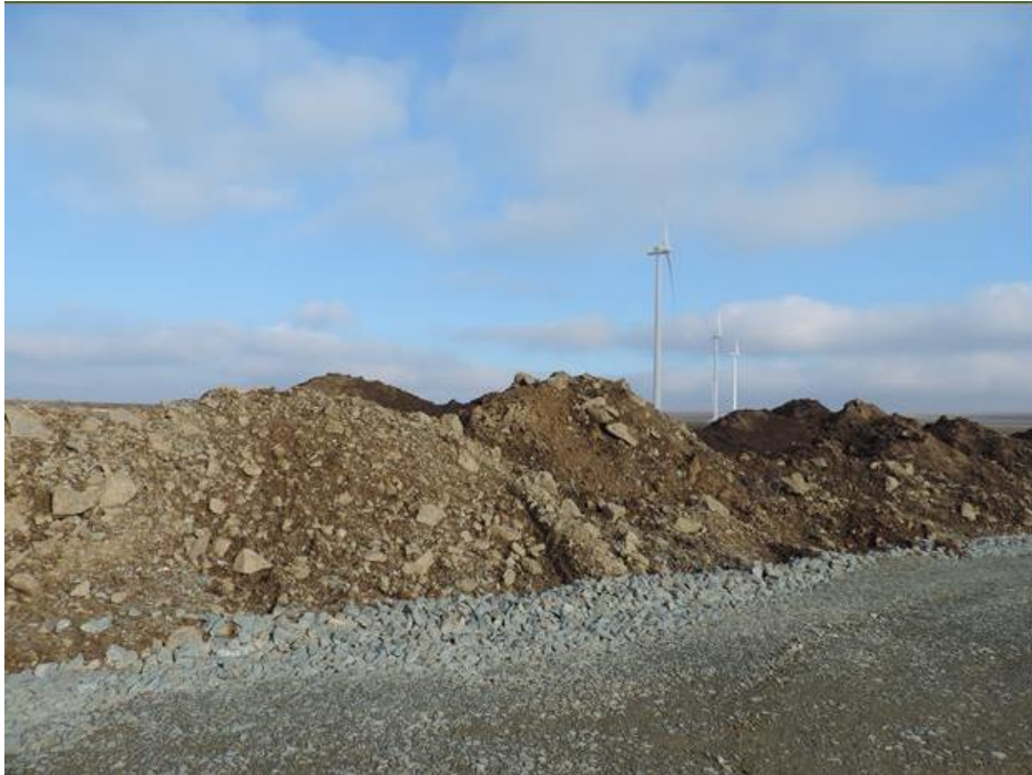
Foto 167 Depozite de material excavat la marginea drumului de acces la turbinele CO_27, CO_28
