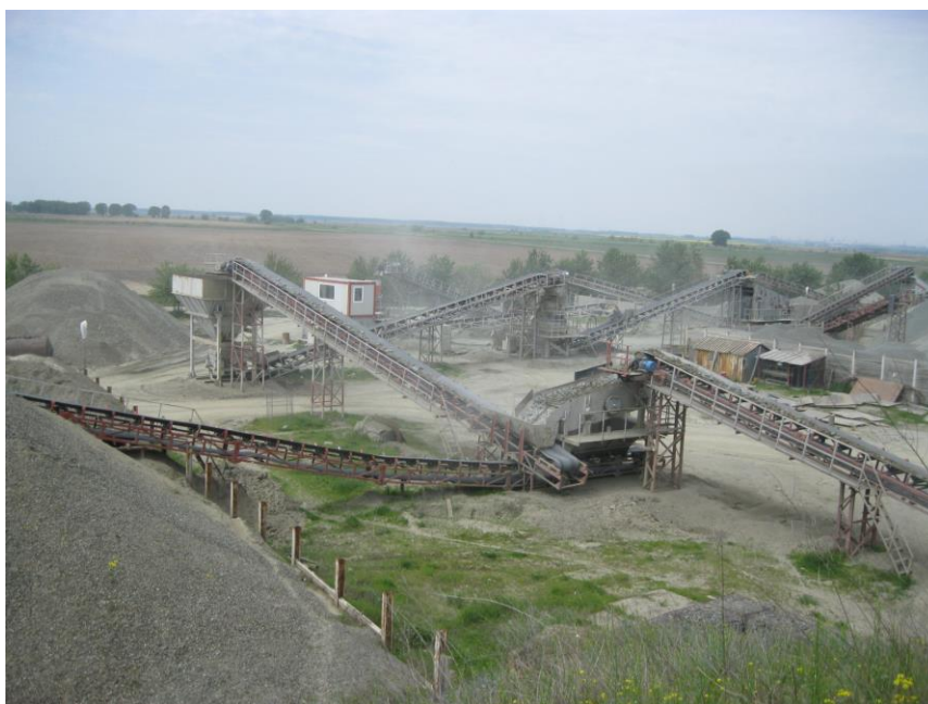
Foto 2. Organizarea de santier a a carierei Dealul Nisipariei
