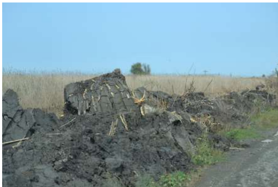
Fig. 21 – lucrari de consolidare a digurilor de incinta
