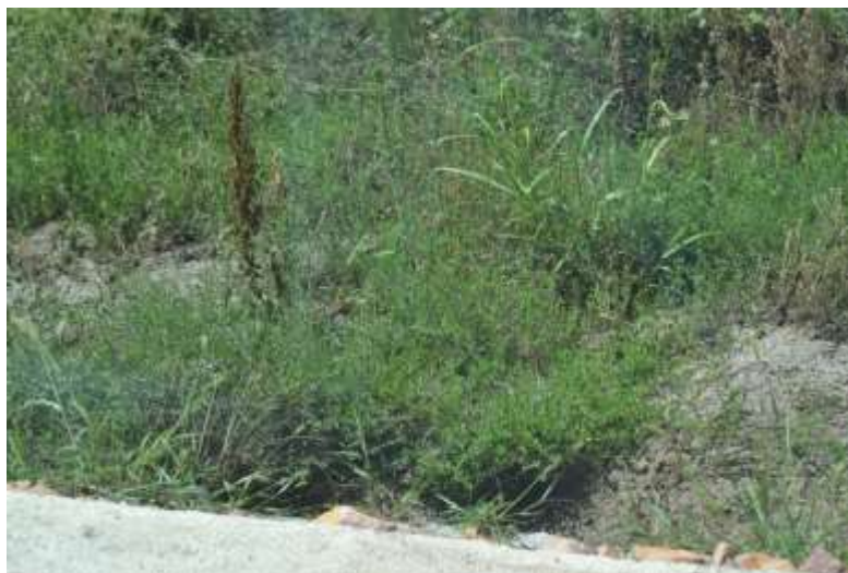
Fig.7 – taluz de drum cu vegetatie spontana
