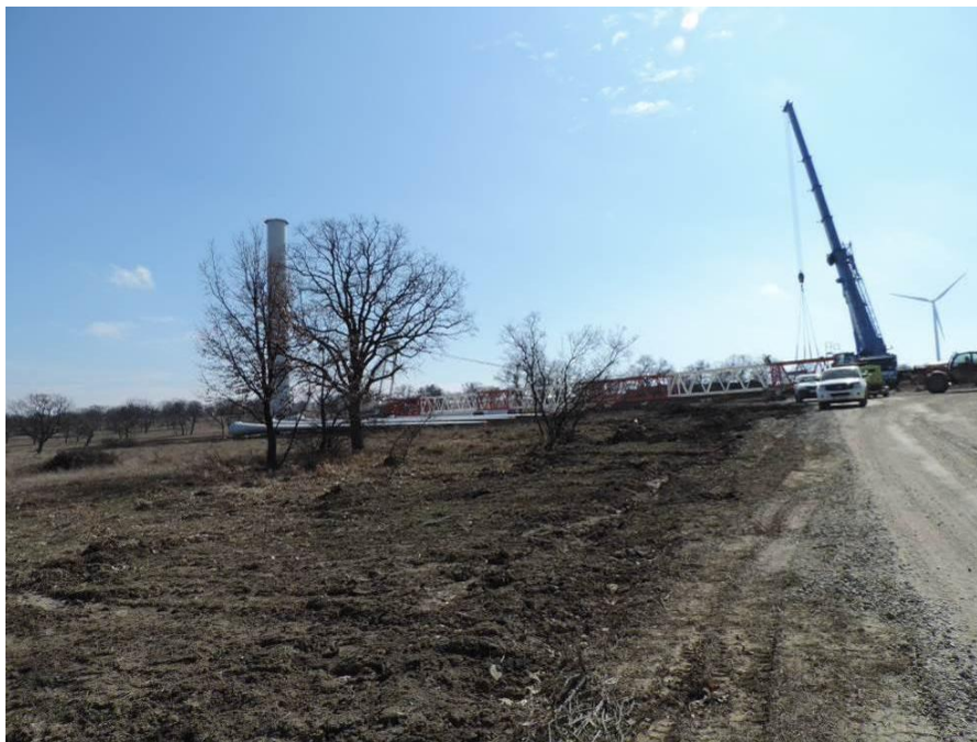
Figura nr. 9 Aspect privind realizarea lucrărilor de construire a parcului eolian SC ELECTRICOM SA, in zona habitatului de pădure de stejar pufos, (martie 2015). Se observă curățarea și nivelarea solului în zonele care au fost afectate de execuția lucrărilor.
