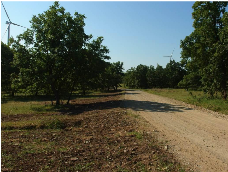
Figura nr. 13 Nivelarea solului și înlăturarea depozitelor de pământ pe suprafețe unde au fost săpate șanțuri de pozare a cablurilor electrice, la marginea habitatului de pădure de stejar pufos (mai 2015).
