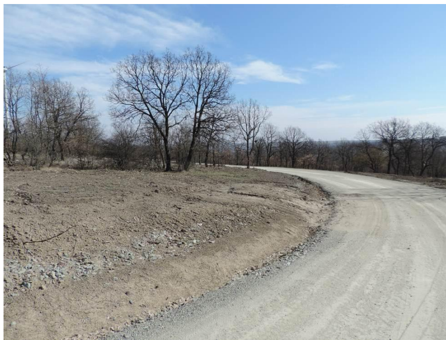
Figura nr. 10 Aspect al pădurii de stejar pufos (habitat 91AA Vegetație forestieră pontosarmatică cu stejar pufos) din zona drumului care a fost construit în vederea accesului către o turbină a parcului eolian SC ELECTRICOM SA. Se observă eliberarea solului și a vegetației de depozite de pământ excavat (martie 2015).
