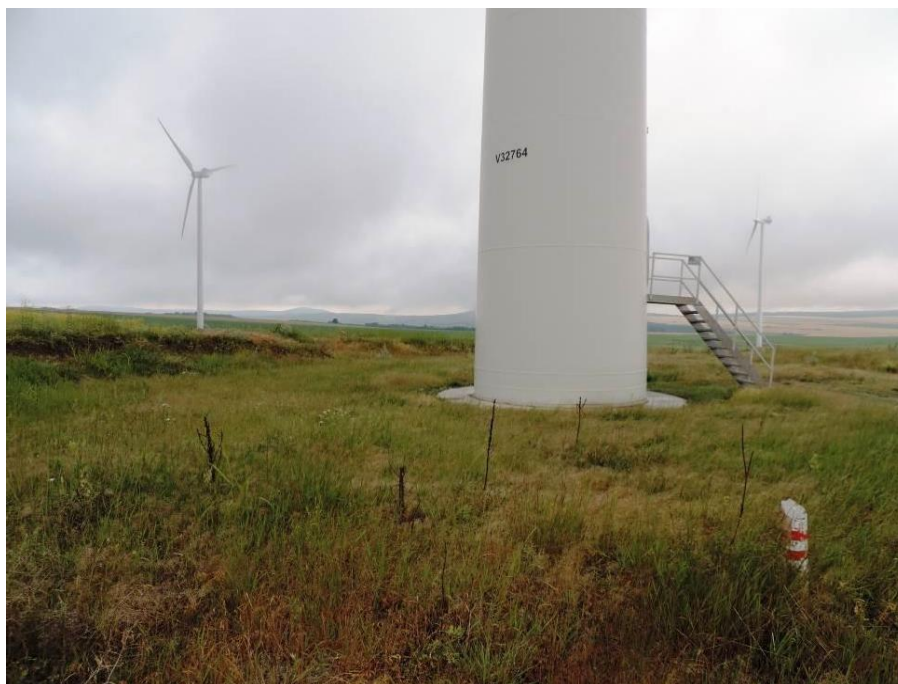
Figura nr. 39. Aspect al covorului vegetal instalat pe suprafața platformei tehnologice a turbinei TO_03
