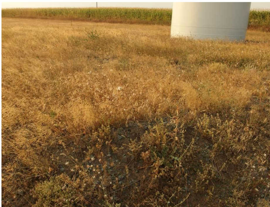
Figura nr. 63. Aspect al covorului vegetal instalat pe suprafața platformei tehnologice a turbinei TO_02 (august 2015)
