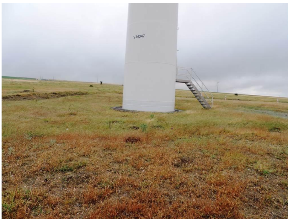
Figura nr. 34. Aspect al covorului vegetal instalat pe suprafața platformei turbinei TO_05
