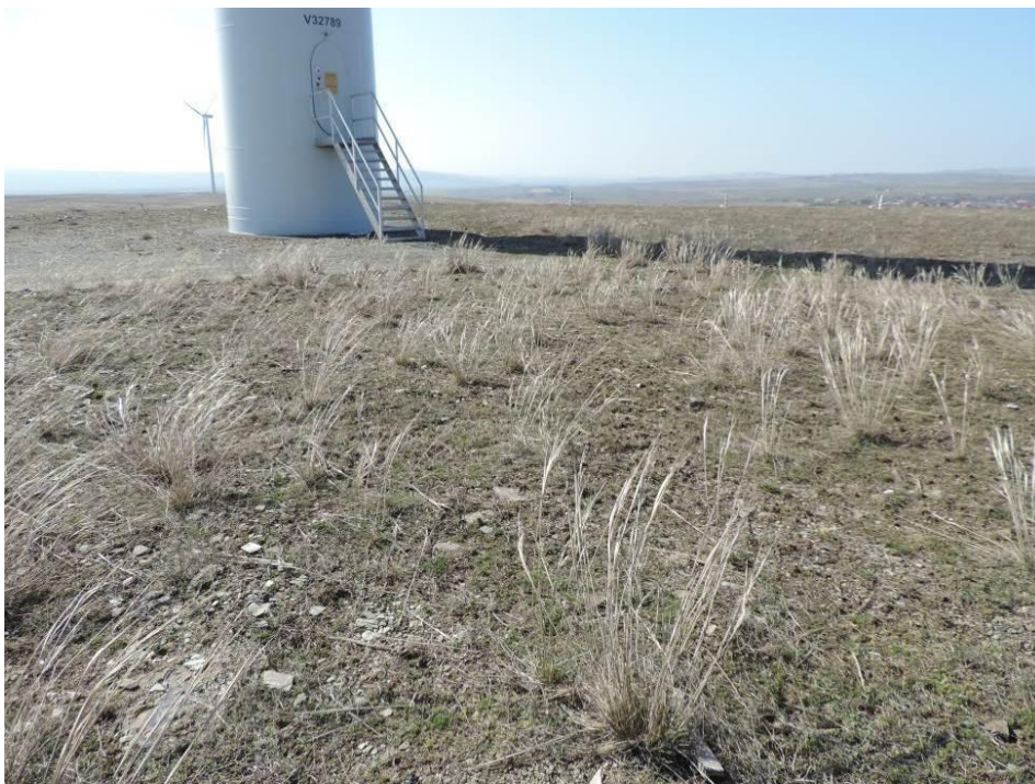
Figura nr. 10. Aspect al covorului vegetal instalat pe suprafața platformei tehnologice TO_08
