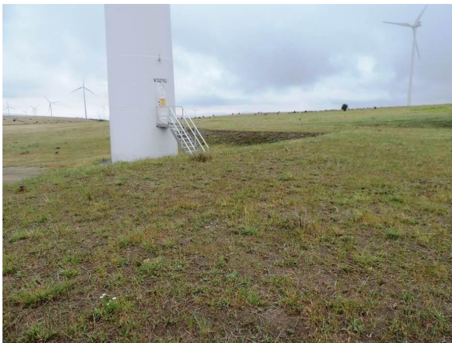
Figura nr. 43. Aspect al covorului vegetal instalat pe suprafața platformei tehnologice a turbinei TO_01
