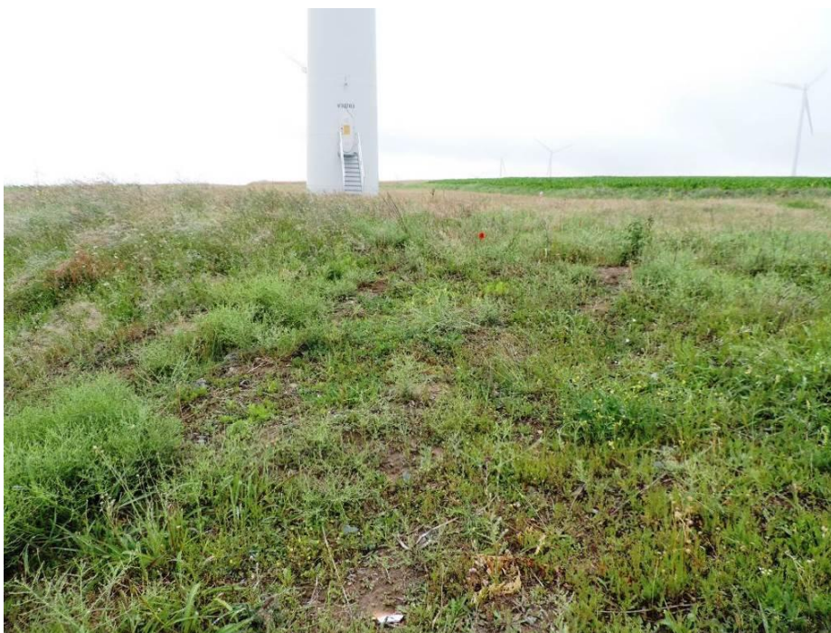
Figura nr. 36. Aspect al covorului vegetal instalat pe suprafața platformei tehnologice a turbinei TO_02
