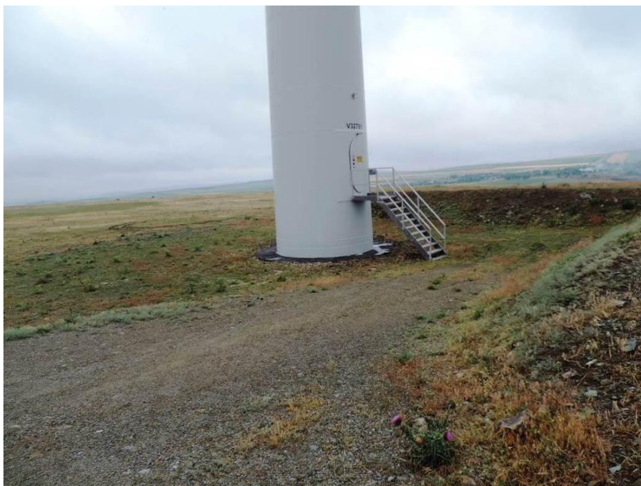
Figura nr. 27. Aspect al covorului vegetal instalat pe platforma tehnologică a turbinei TO_10 (iunie 2015)
