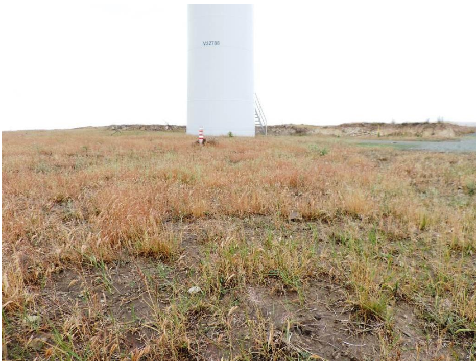
Figura nr. 31. Aspect al covorului vegetal instalat pe suprafața platformei TO_07 (iunie 2015)
