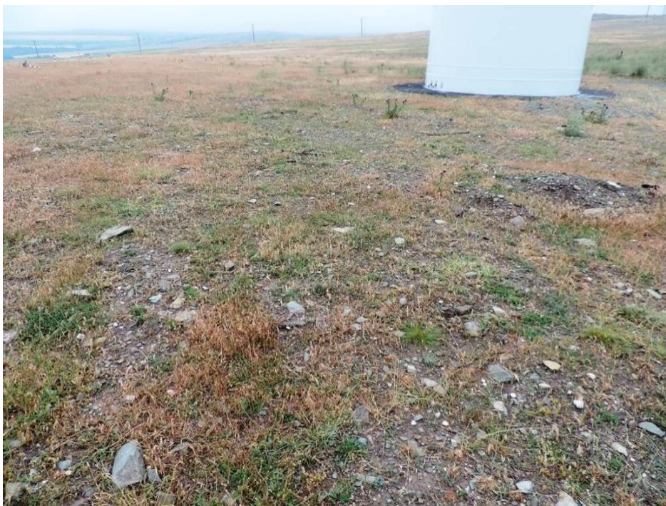
Figura nr. 26. Aspect al covorului vegetal instalat pe platforma tehnologică a turbinei TO_09
