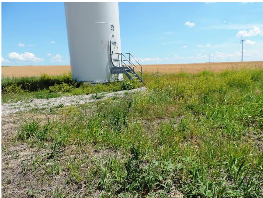
Figura nr. 43 Aspect al vegetației instalate pe platforma tehnică a turbinei SB_49, cu împrejurimi de culturi de grâu ( Triticum aestivum ) (iunie 2015)
