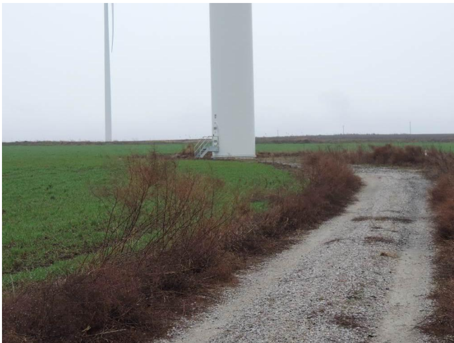
Figura nr. 11: Aspect prevernal al culturilor de cereale din amplasamentul parcului eolian Sălbatica II ce se întind până în proximitatea turnului turbinelor eoliene (martie 2015)
