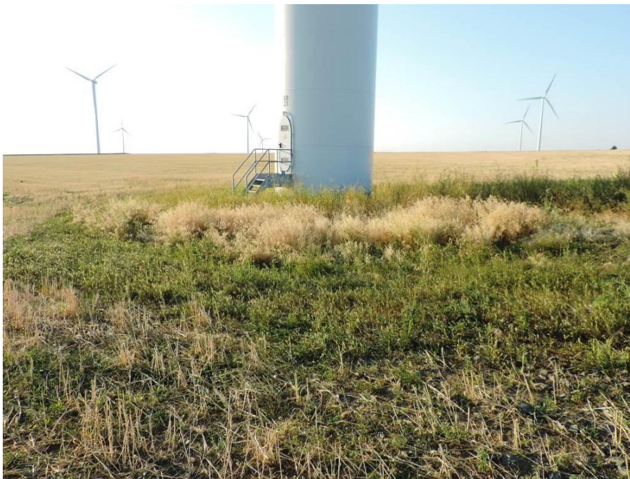
Figura nr. 45 Aspect al covorului vegetal instalat pe platforma tehnologică a turbinei SB_23 (iulie 2015)
