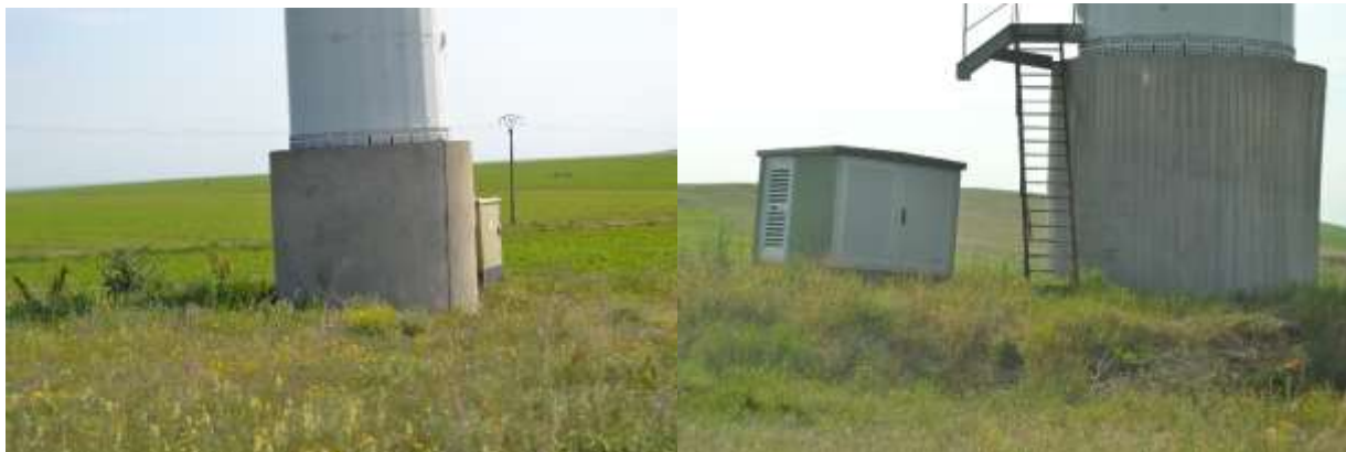
Fig. 4-5 – specii de plante identificate pe taluzul turbinelor si traseul electric
