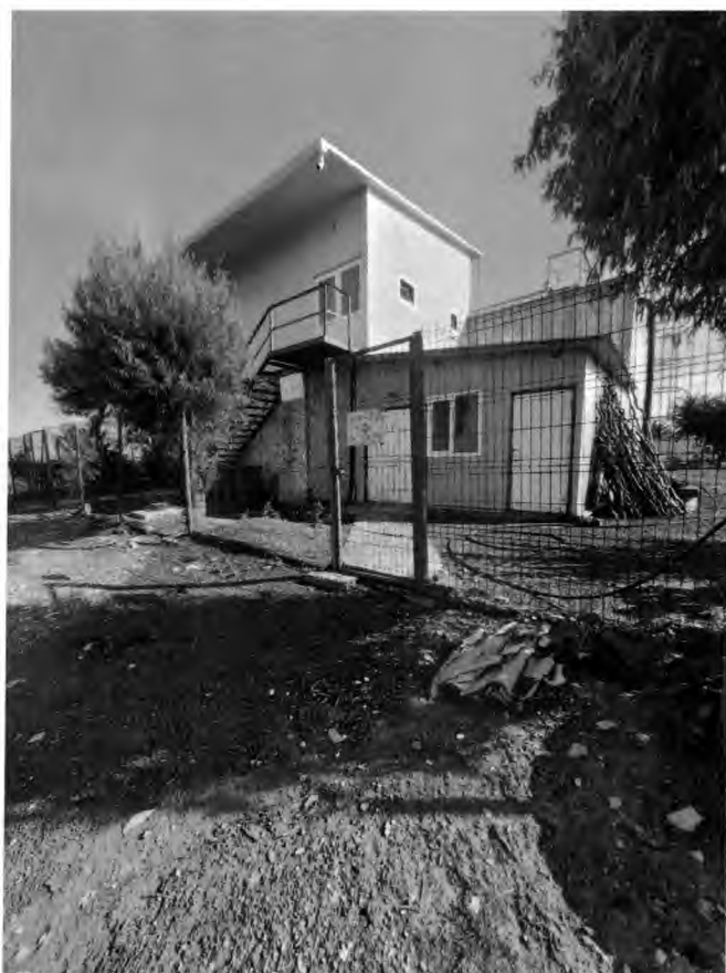
Zona statie de epurare
