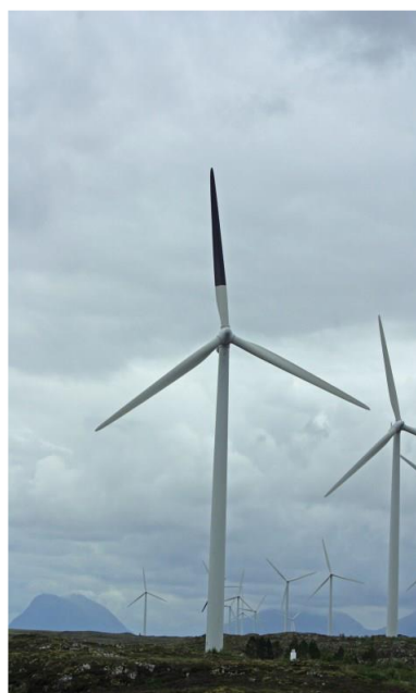
Fig.54- pala turbina eoliانا (2/3 din lungime ) vopsita in negru
