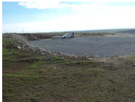
Fig.2- platforme de lucru -foto original Badea Gh.
