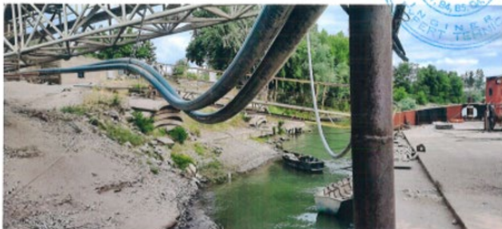
Foto 12. Taluz ponton de acostare
