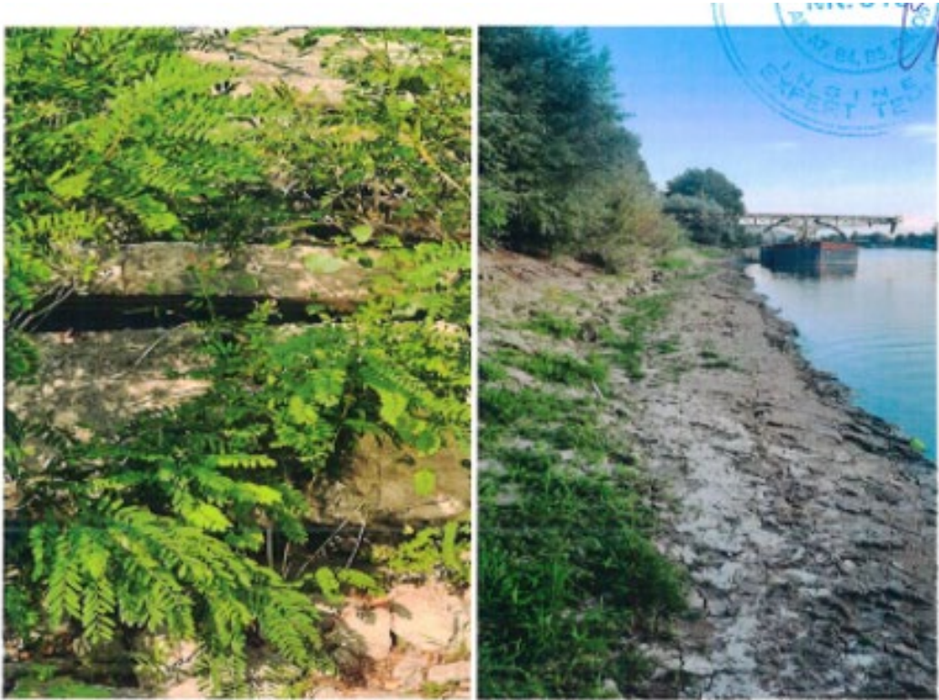
Foto 15. Grindă susținere protecție pereu – taluz amonte front încărcare
