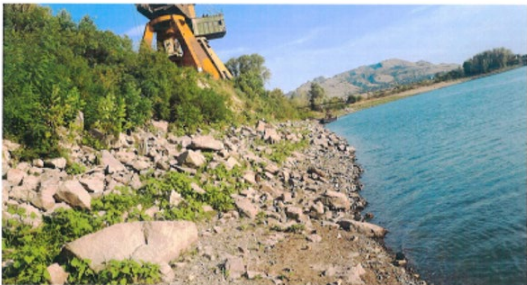
Foto 9. Protecție anrocamente taluz
