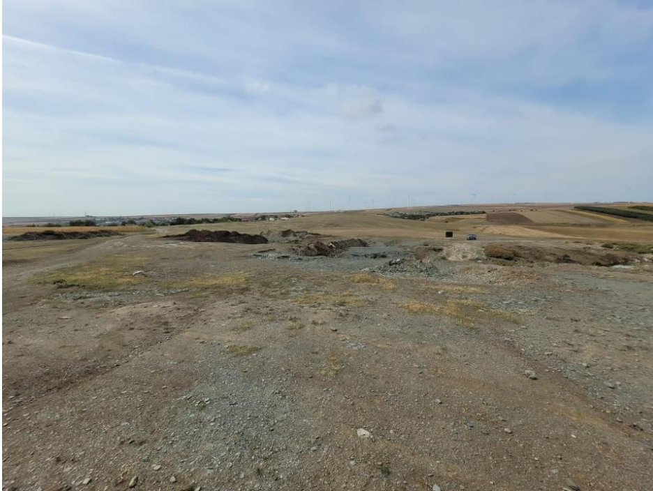
Aspect vedere amplasament
