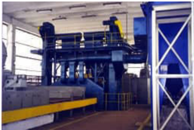
Figura 11 – Linia de sablare – vopsire (pasivizare) – Sectia Debitare
