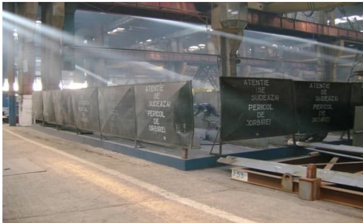
Figura 57 – Amenajarea imprejmuire zona sudura
