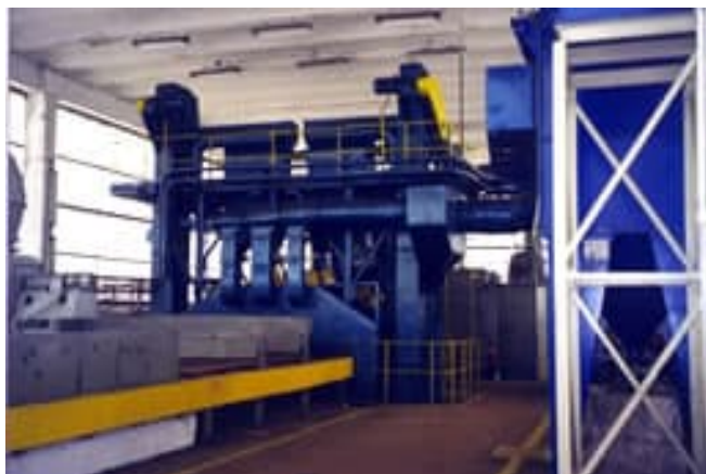
Figura 11 – Linia de sablare – vopsire (pasivizare) – Sectia Debitare
