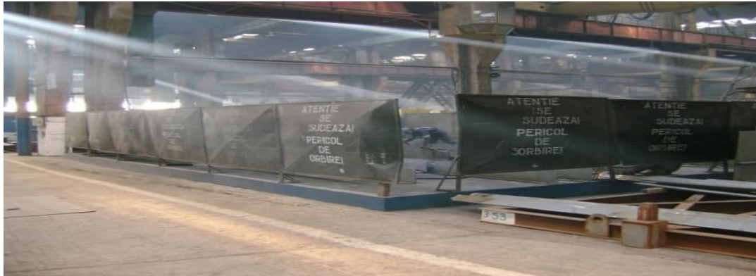
Figura 58 – Amenajarea imprejmuire zona sudura
