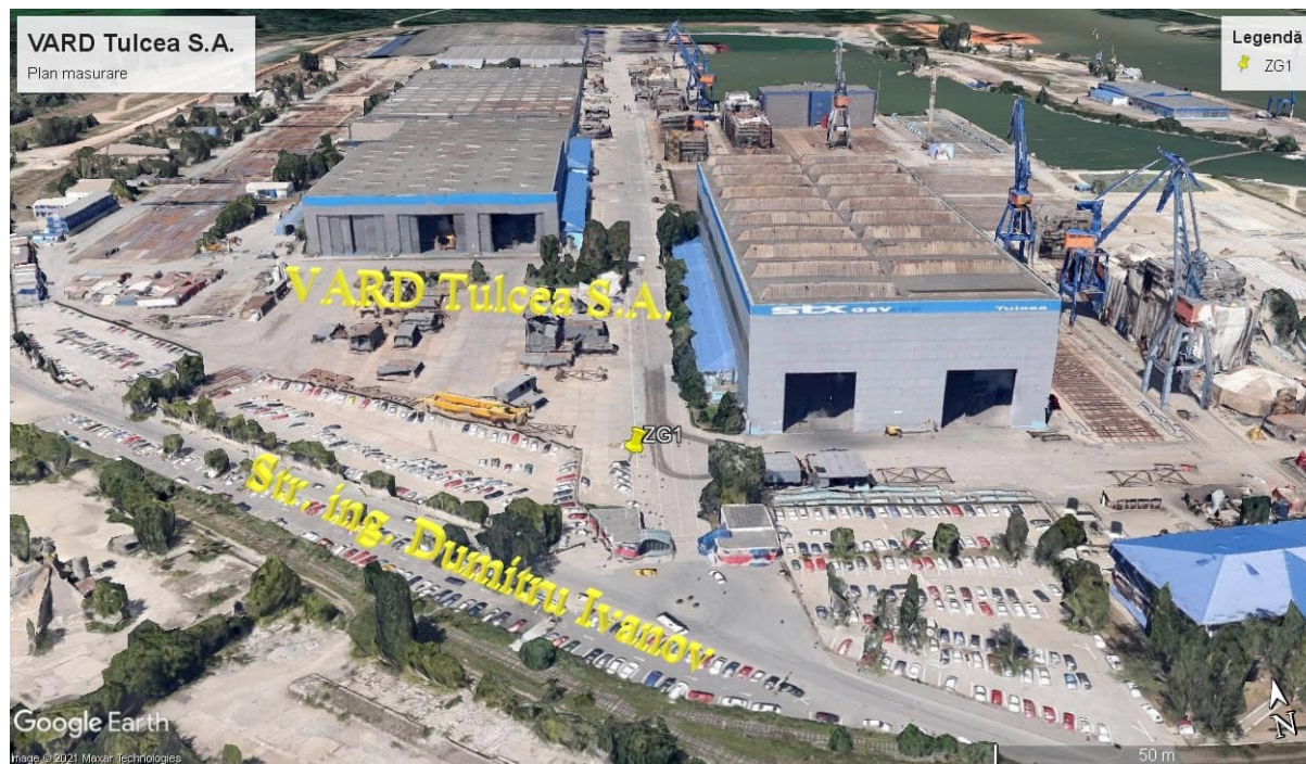
Figura 60 – Amplasarea punctelor de masurare in cadrul santierului naval VARD Tulcea S.A. (imagine satelitara)
