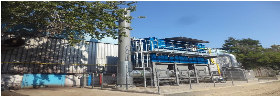
Figura 10 – Amplasare cos dispersie instalatie RTO
