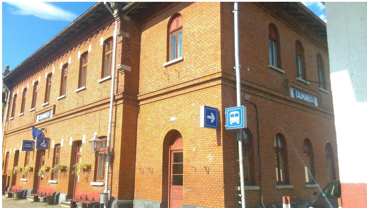
Figură 21. Clădirea gării din Călimănești
