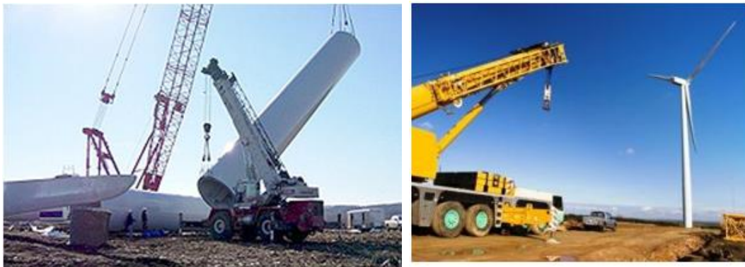
Aspecte din timpul execuției lucrărilor la un parc eolian
