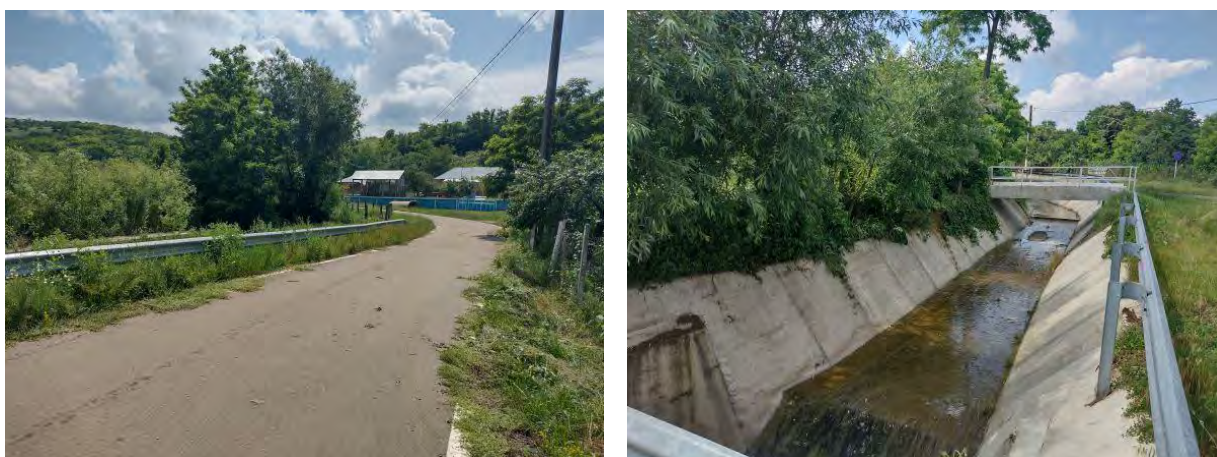
Figura 44 – Amplasamentul unde lucrarile propuse intersecteaza aria protejata – sat Barzesti
