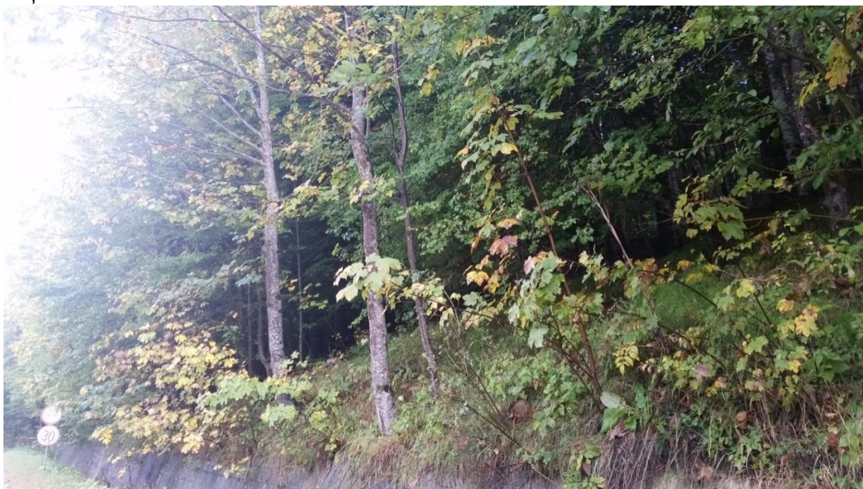
Figura 21 - Arboret de frasin Ulmus glabra și paltin de munte Acer pseudoplatanus ( Acereto – Ulmetum ), fitocenoze asemanatoare celor din habitatul 9180* pe taluzul pietros artificial creat al DN 71 între km 96 și 97.
