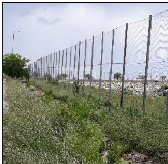
Figura 28 Împrejmuire de protecție suplimentară
