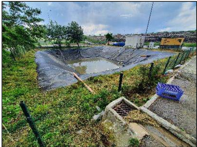
Figura 21 Bazinul pentru apa de incendiu
