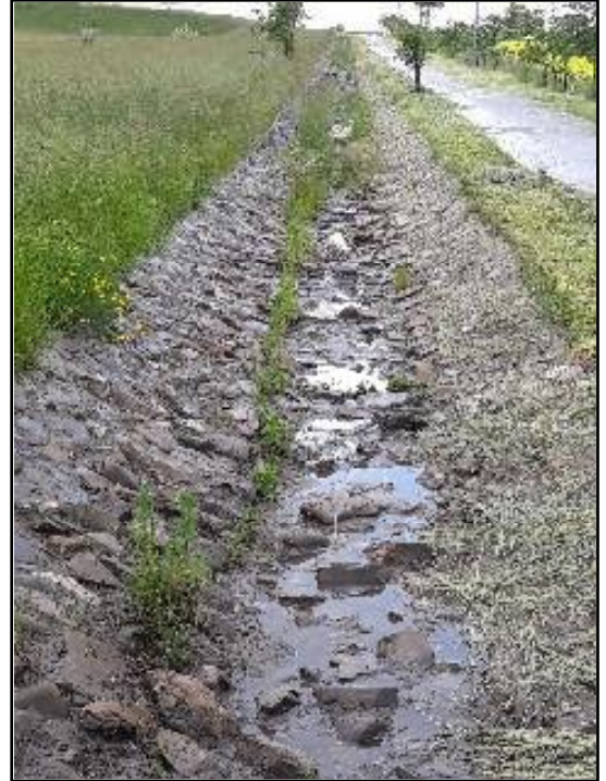
Figura 18 Rigola perimetrală
