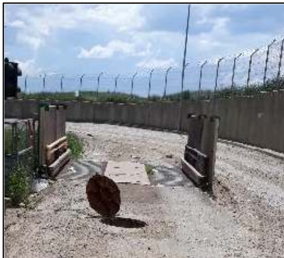
Figura 10 Platformă spălare roți
