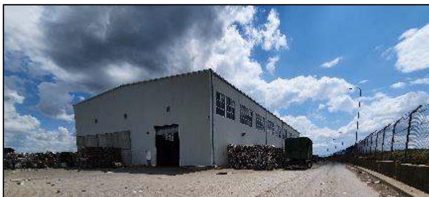
Figura 15 Stație de sortare deșeuri reciclabile
