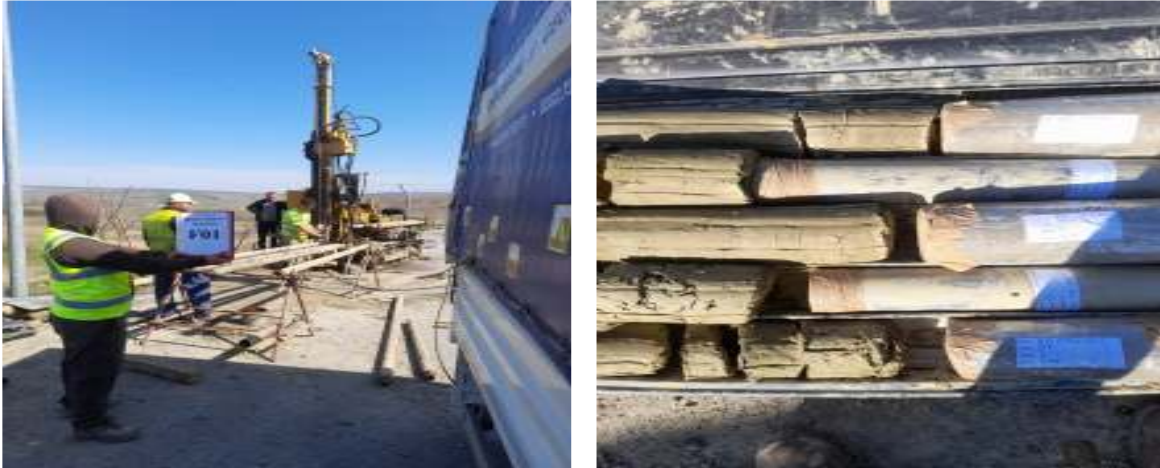
Figura 31 Realizare foraje și prelevare probe eșantioane de pământ
