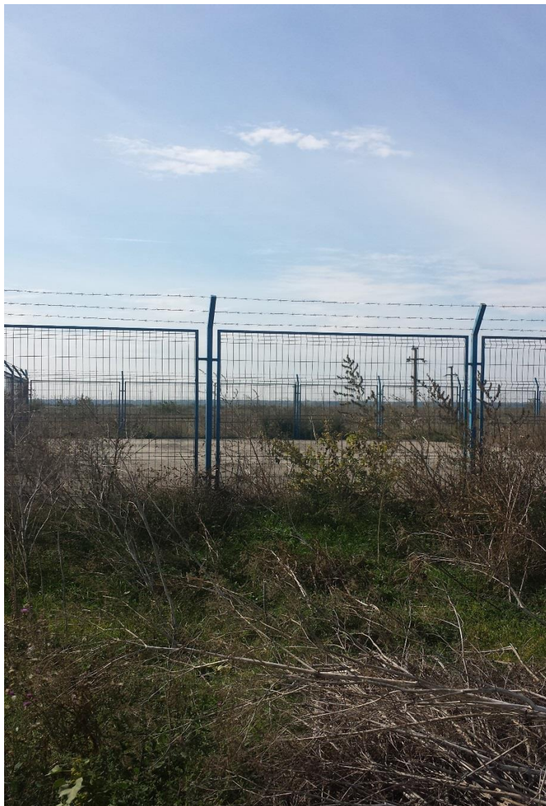
Figura 5: Amplasament SEAU propus Cazanesti – suprapunere cu siturile ROSPA0152 Coridorul lalomitei și ROSCI0290 Coridorul lalomitei
