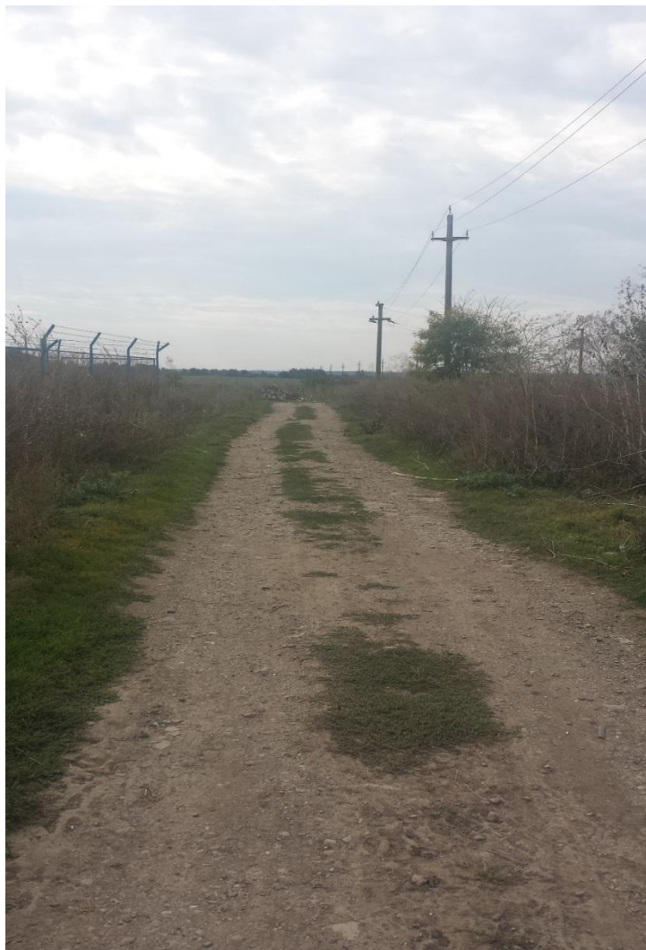
Figura 6: Acces amplasament SEAU propus Cazanesti, str.lalomitei – suprapunere cu situl ROSPA0152 Coridorul Ialomitei
