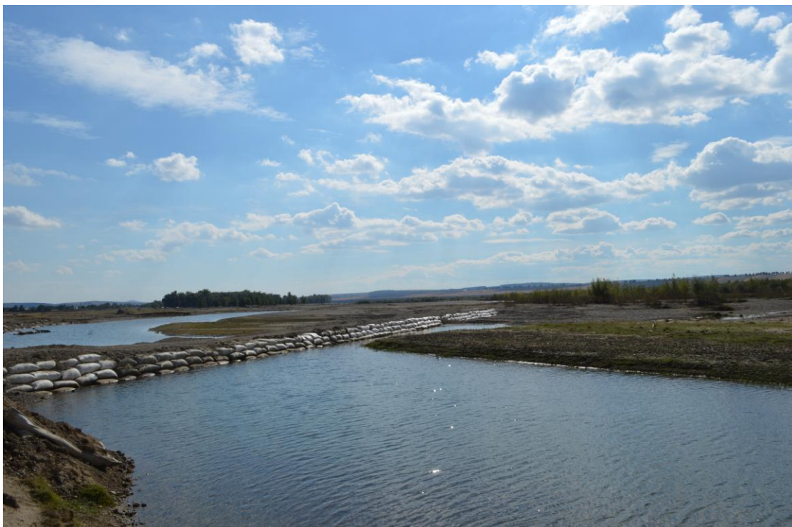
Aspecte ale conservării nefavorabile ale habitatelor din ROSCI0363 – eroziune, inundație
