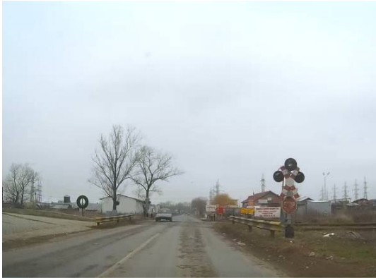
Figura 36: Exemplu de trecere la nivel cu calea ferată amenajată necorespunzător, Iași, Șoseaua Iași-Tomești
