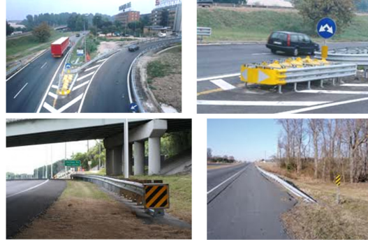
Figura 28: Dispozitive de protecție corespunzătoare (Sursă: Manual de siguranță rutieră pentru Rep. Moldova. Administrația de Stat a Drumurilor, 2011)
