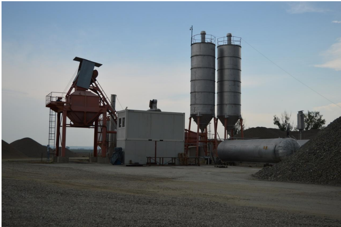
Instalație de preparare mixturi asfaltice
