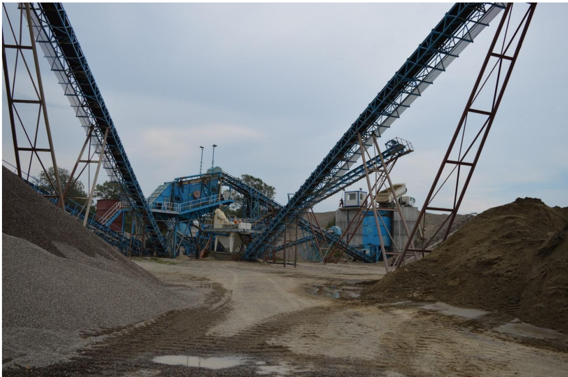
Stație sortare existentă pe amplasament
