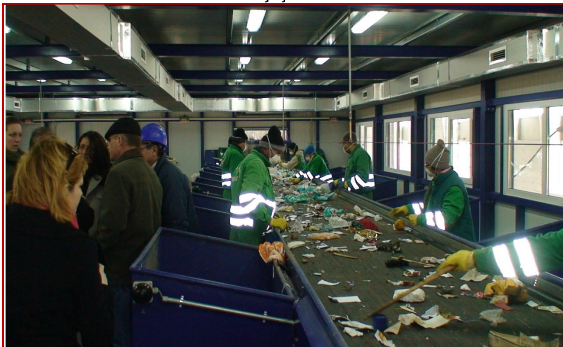
Figura VII.1.3.2.12. Incinta stației de sortare a deșeurilor reciclabile din cadrul depozitului Țuțora
