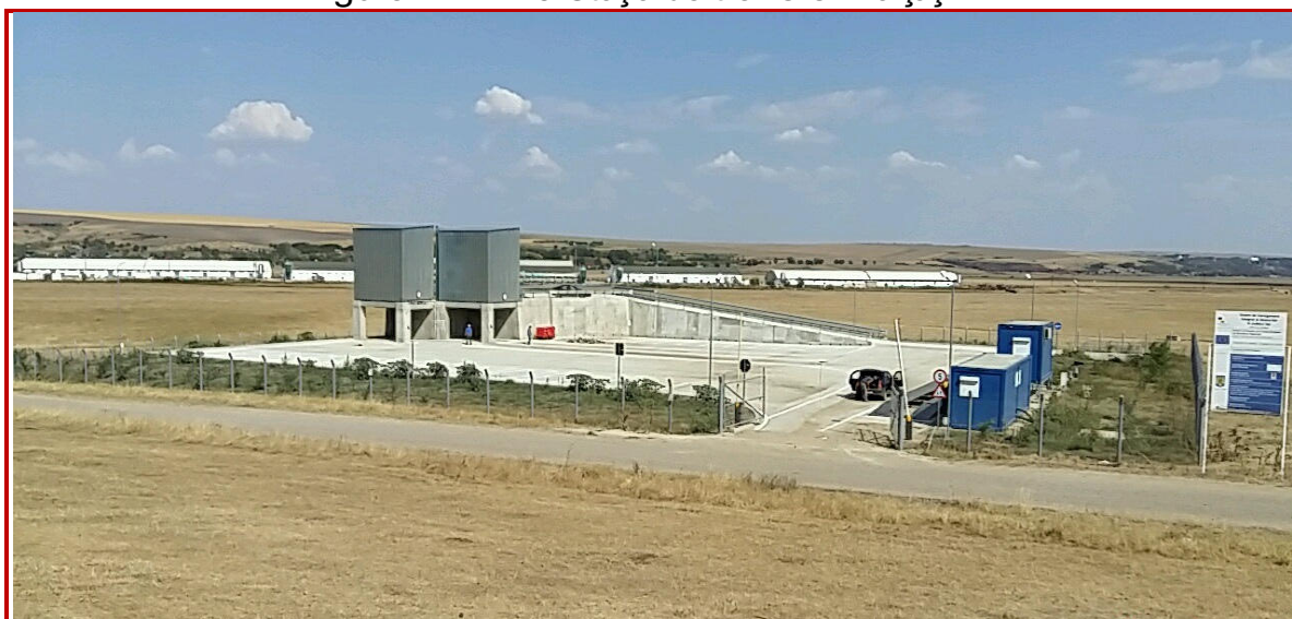
Figura VII.1.1.9.Stația de transfer Bălțați
