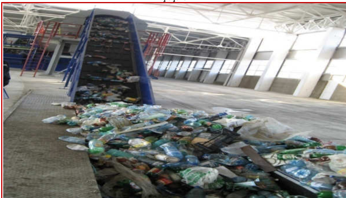
Figura VII.1.3.2.6. Incinta stației de sortare a deșeurilor reciclabile din cadrul depozitului Țuțora
