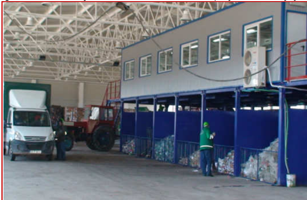
Figura VII.1.3.2.9. Deșeuri sortate în vederea balotării (stația de sortare Țuțora )
