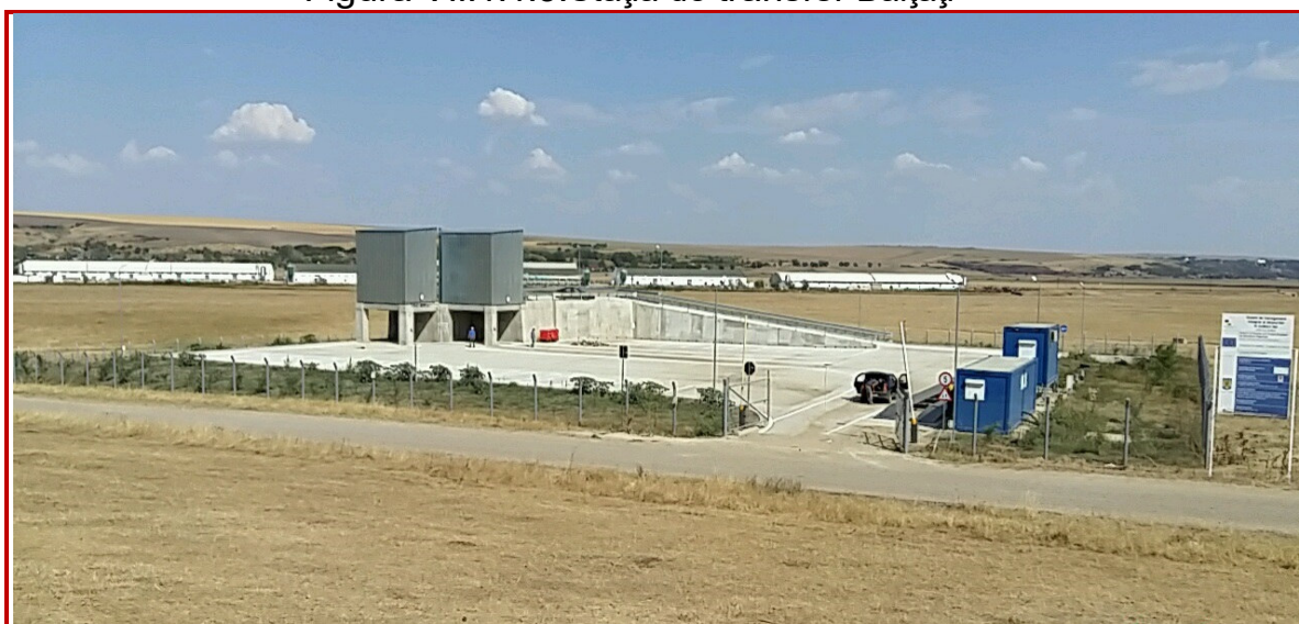
Figura VII.1.1.9.Stația de transfer Bălțați
