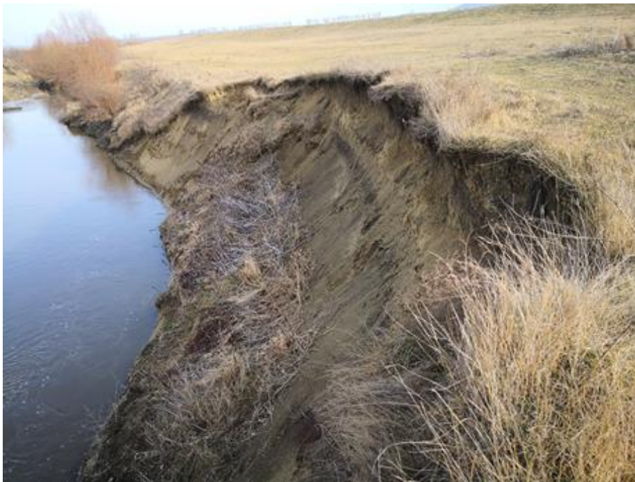
Figura 6. Mal puternic erodat ce urmează să fie consolidat cu prism din anrocamente
