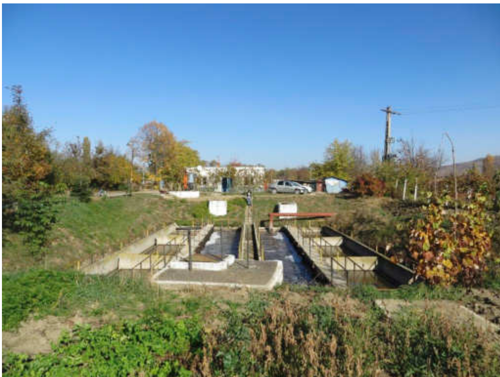
Figura 2-50 SEAU Tibanesti (demolare si construire statie noua)
