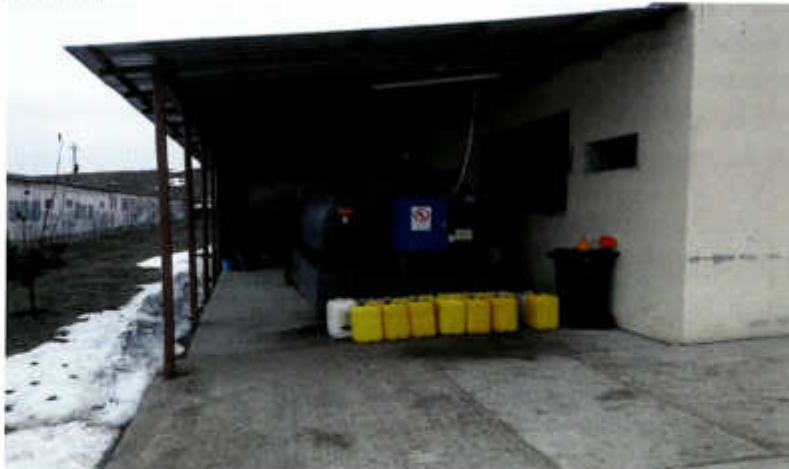
Depozitul de motorină
