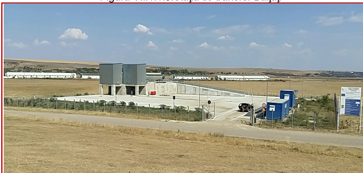
Figura VII.1.1.9.Stația de transfer Bălțați
