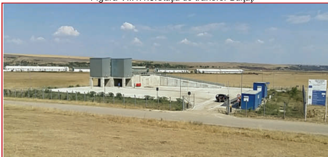
Figura VII.1.1.9.Stația de transfer Bălțați
