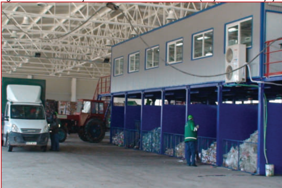
Figura VII.1.3.2.13. Deșuri sortate în vederea balotării (stația de sortare Țuțora )
