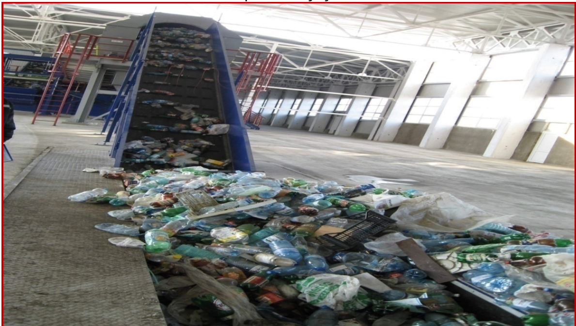
Figura VII.1.3.2.10. Incinta stației de sortare a deșeurilor reciclabile din cadrul depozitului Țuțora
