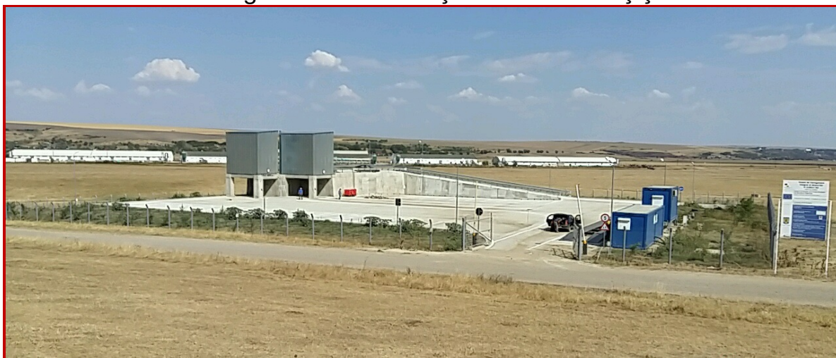
Figura VII.1.1.11.Stația de transfer Bălțați
