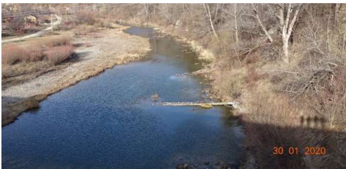
Figura nr. 1. Vedere asupra subtraversării râului Bistrița în zona localității Vișoara
