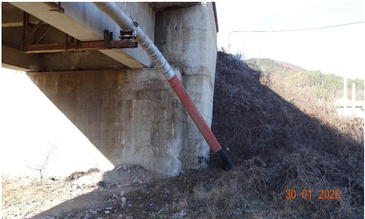
Figura nr. 3. Vedere de pe malul drept al Râului Bistrița (punct intrare în pământ a traversării aeriene existente)
