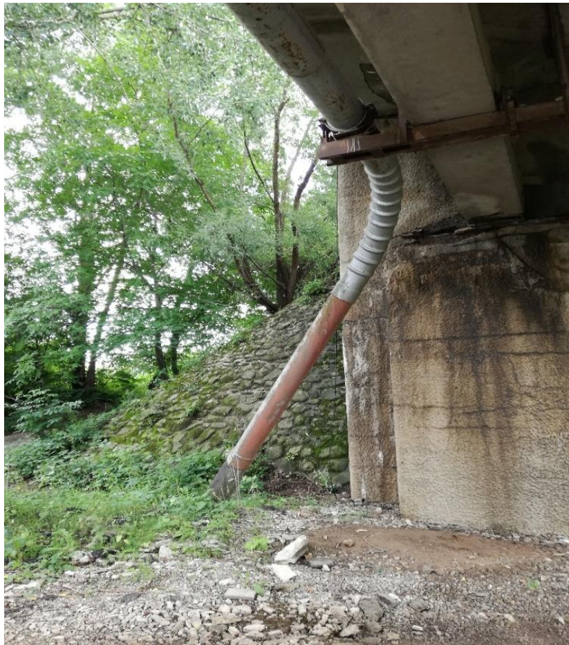
Figura nr. 2. Vedere de pe malul drept al Râului Bistrița (punct ieșire din pământ a traversării aeriene existente)
