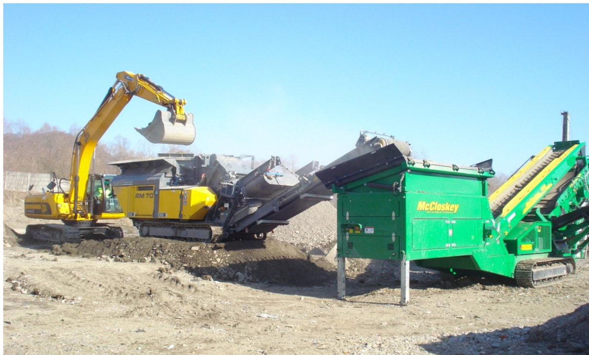
Fig. VII.1.1.6. Stație de preluare și prelucrare a deșeurilor provenite din construcții și demolări - Mediaș
