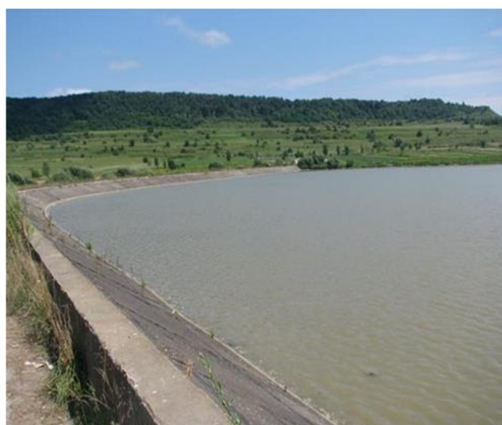
Fig. II.2.1.2.3. Lacul de acumulare Arpașu
