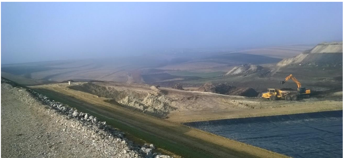
Figură 4. Imagine dispunere geomembranei pe pantele depozitului
