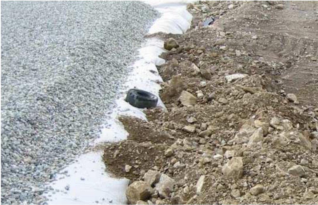
Figură 3. Imagine dispunere strat mineral sau strat sintetic –geocompozit bentonitic
