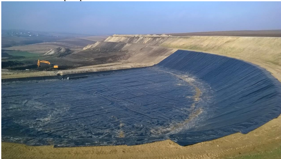
Figură 5. Imagine dispunere geomembranei pe pantele depozitului
