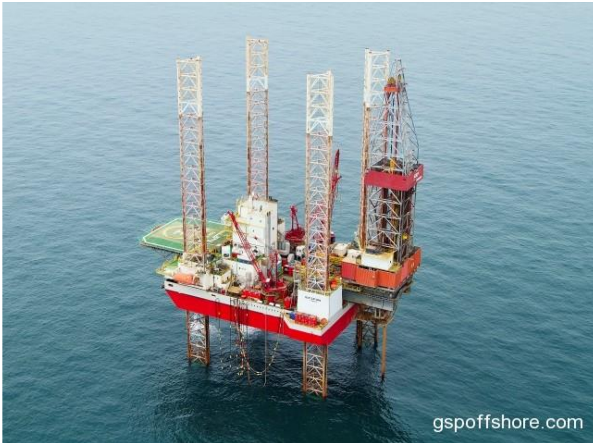
Figura 2 - Platforma mobila autoridicatoare de foraj marin GSP Saturn
