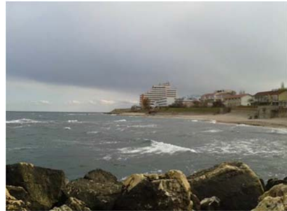
Sectiune de plaja situata la sud de structura costiera C1
