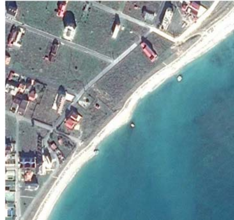
Cazemate din beton de-a lungul secțiunii nordice a celei de plajă 1
