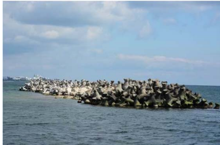
Completari cu stabilopozii a structurii M3
