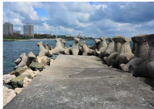
Dale crapate, surpate, subspalari ale nucleului de piatra nesortata si dislocari ale stabilopozilor
