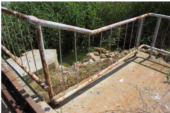
Degradare structuri metalice si beton
