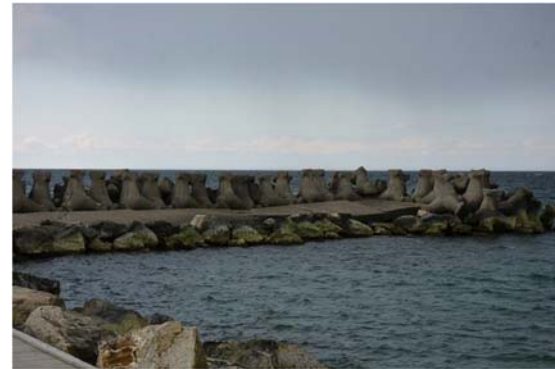
Zona cu subsalari ale nucleului dale crapate si dislocate
