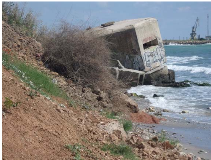
Cazemata zona 2 Mai – viitoare structura de protecție 2MnBS1
