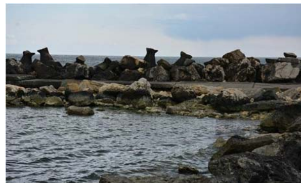
Zona de acumulare a algelor
