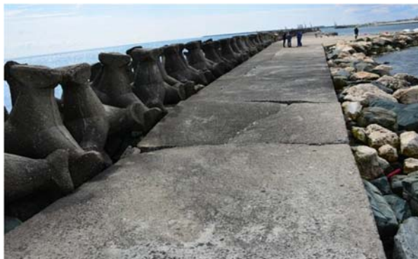
Dale crapate si surpate pe segmentul de dig paralel cu linia tarmului
