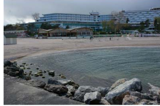
Zona cu destramarea mantalei de protectie din blocuri naturale
