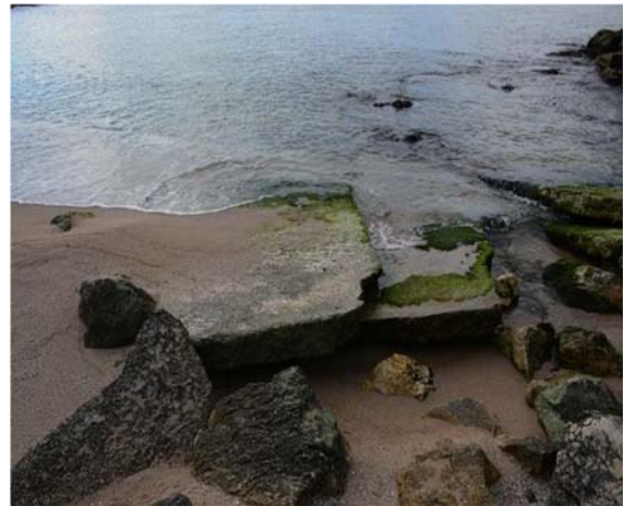
Destramarea mantalei de protecție
