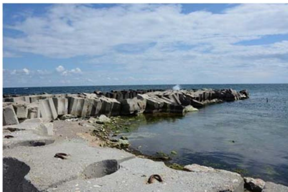
Zona cu blocuri evidente deplasate si dezvoltare intensa a algelor
