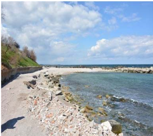
Protectie suplimentara in zona centrala a plajei cu blocuri de piatra si deseuri din constructii
