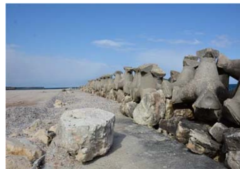
Zona cu stabilizozi deplasați, blocuri de piatră deplasate
