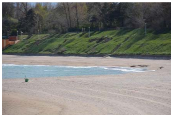
Subsectorul nordic, faleză amenajată pentru promenadă și protejată la bază cu un zid de sprijin
