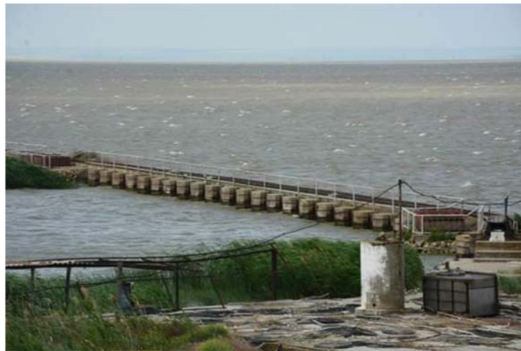
Corp Stăvilărilor Edighiol
