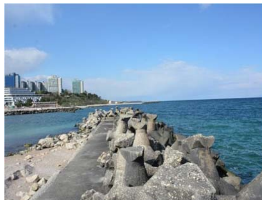
Zona cu destramarea mantalei de protectie din blocuri natural
