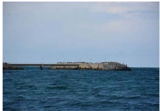
Vedere cu pasarela de legatura intre digul principal si zona de acostare
