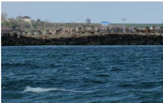
Zona din digul principal de acces al structurii N2
