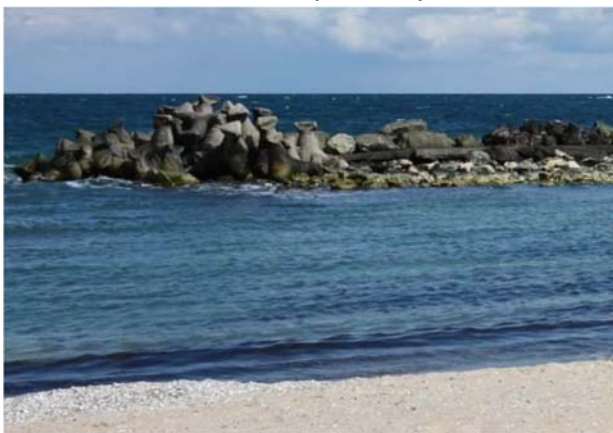
Zona cu dale dislocate si destramarea mantalei de protectie din blocuri naturale
