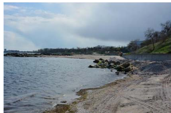
Faleza sustinuta cu un zid de sprijin, protectie suplimentara cu blocuri de piatra a falezei
