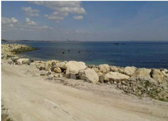
Lipsa de sediment pe partea dinspre mare a protecției din piatră
