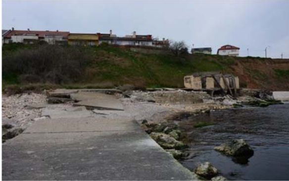
Segment perpendicular pe linia țărmului - dale deplăstate, manta dislocată
