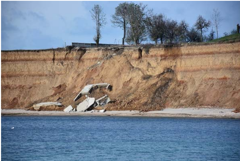
Faleza in curs de erodare in zona de sud a structurii 2M1
