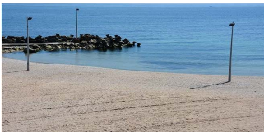
Stabilopozii deplasati si distrusi
