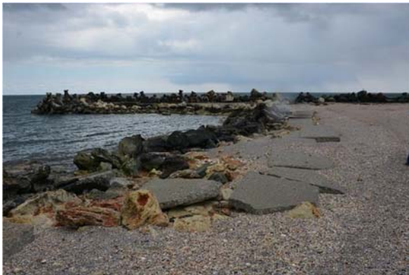
Dale de beton crapecate și deplasate pe segmentul de dig perpendicular pe linia țărmului
