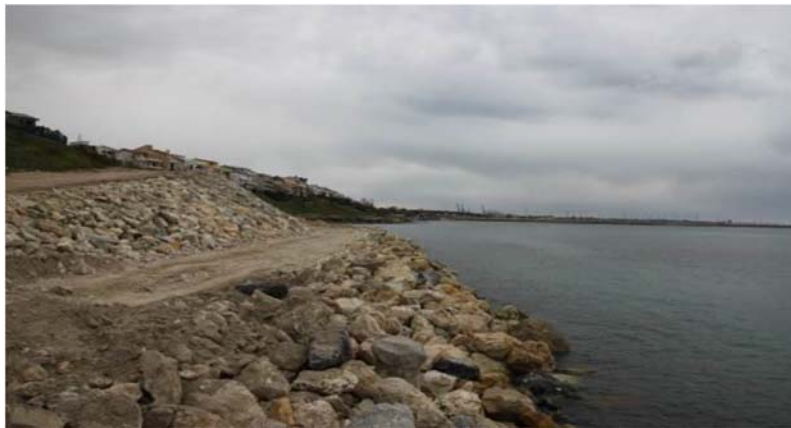
Consolidare drum de acces situat la limita sudica a zonei Agigea (construita in timpul reabilitarii zonei Eforie Nord – la inceputul anului 2015)
