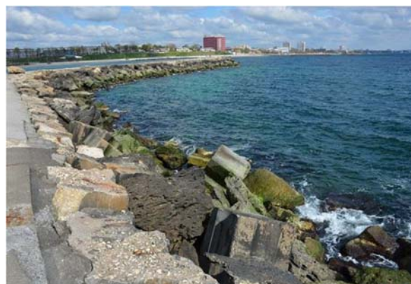
Dislocări ale blocurilor evidente din mantaua de protecție
