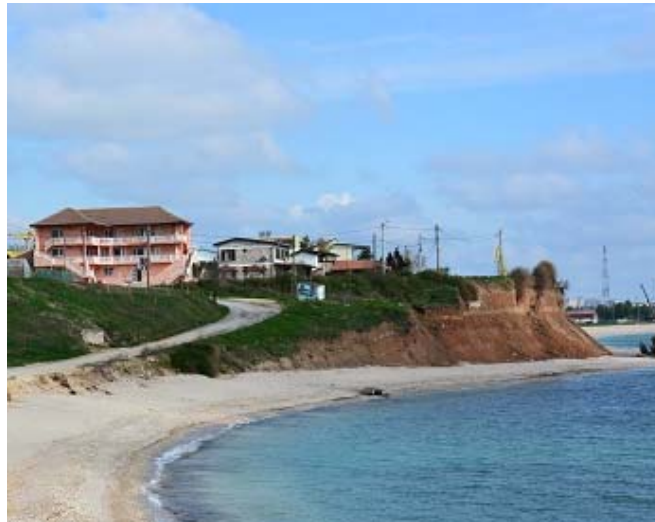
Faleza in curs de erodare in zona de nord a structurii 2M1
