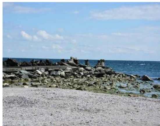
Zona in care nucleul de piatra nesortata este spalat si stabilopozii deplasati
