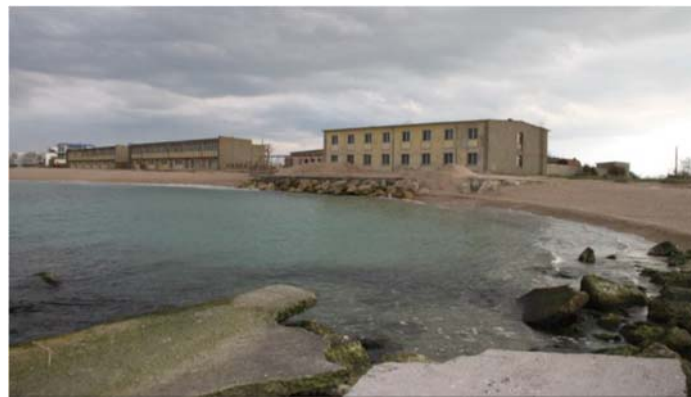
Protectie din piatra in centrul celulei de plaja 1a pentru stoparea eroziunii (aprilie 2015). Acest lucru nu era necesar inca in anul 2012
