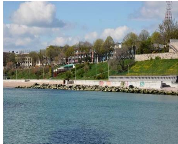
Faleza si plaja in zona centrala a sectorului M1-M2, protejata suplimentar cu blocuri de piatra
