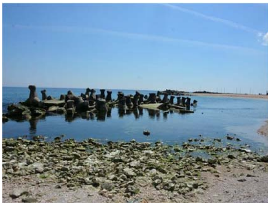
Zona de destramare a mantalei de protecție
