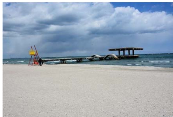
Structura amenajata pentru promenada situata in zona structurii de protectie MM5
