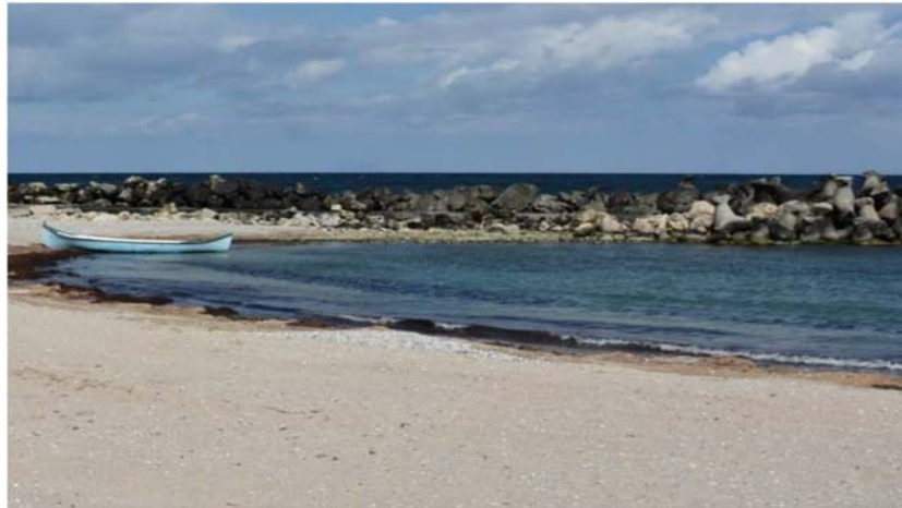
Zona cu mantaua destramata si stabilopozii deplasati
