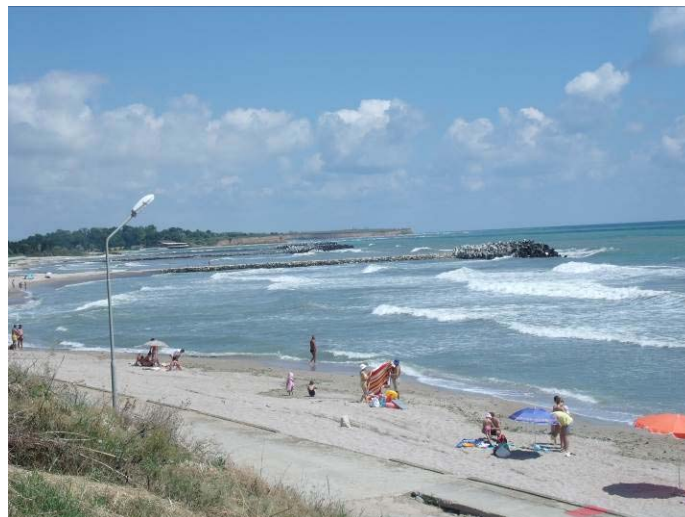
Vedere structuri O5, O6, O7
