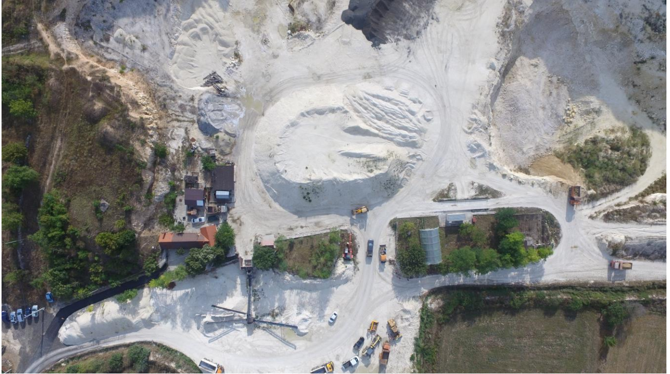
Figura 21. Imagine de ansamblu asupra vetrei de carieră la nivelul căreia se disting: zona organizării de șantier, stația de concasare/sortare, conurile de depozitare a sorturilor obținute, utilajele de lucru
