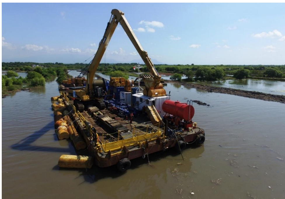
Foto 3: Săparea șanțului pentru traversare Balta Mare și Balta de Mijloc cu excavator plutitor (pentru adâncimi mari ale apei)
