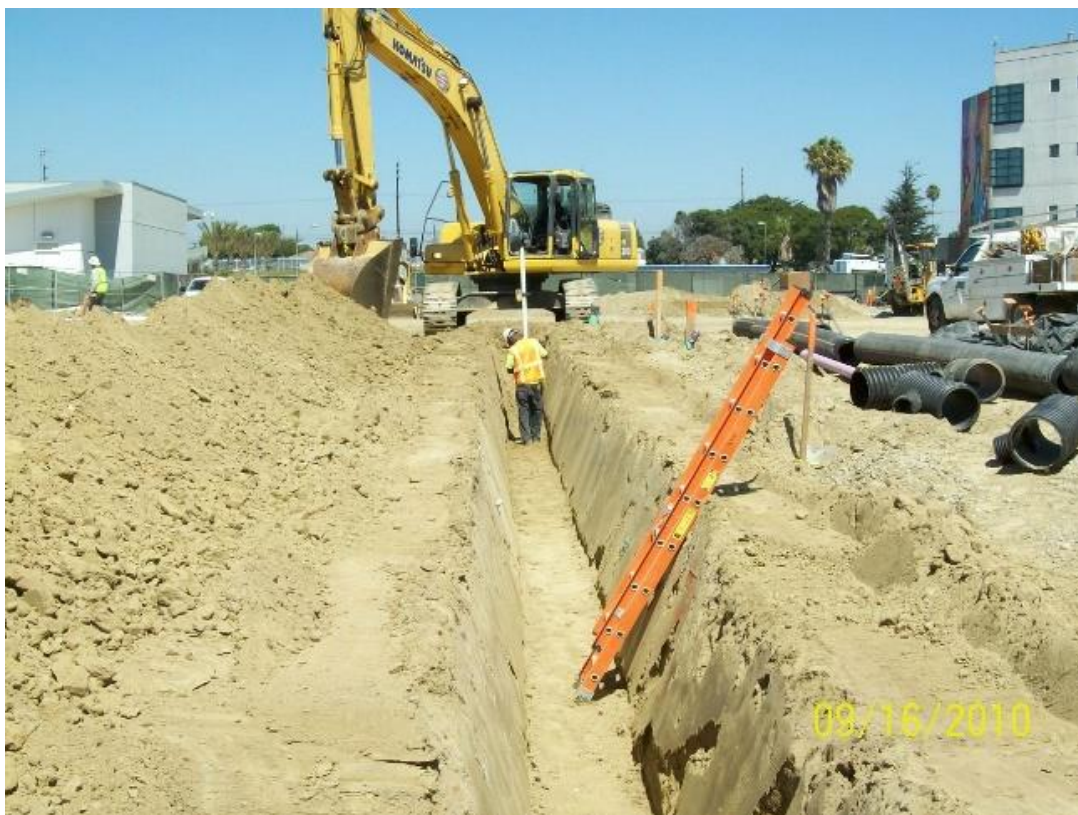
Foto 1: Săparea șanțului cu echipament mecanizat: excavator cu cupă normală sau profilată
