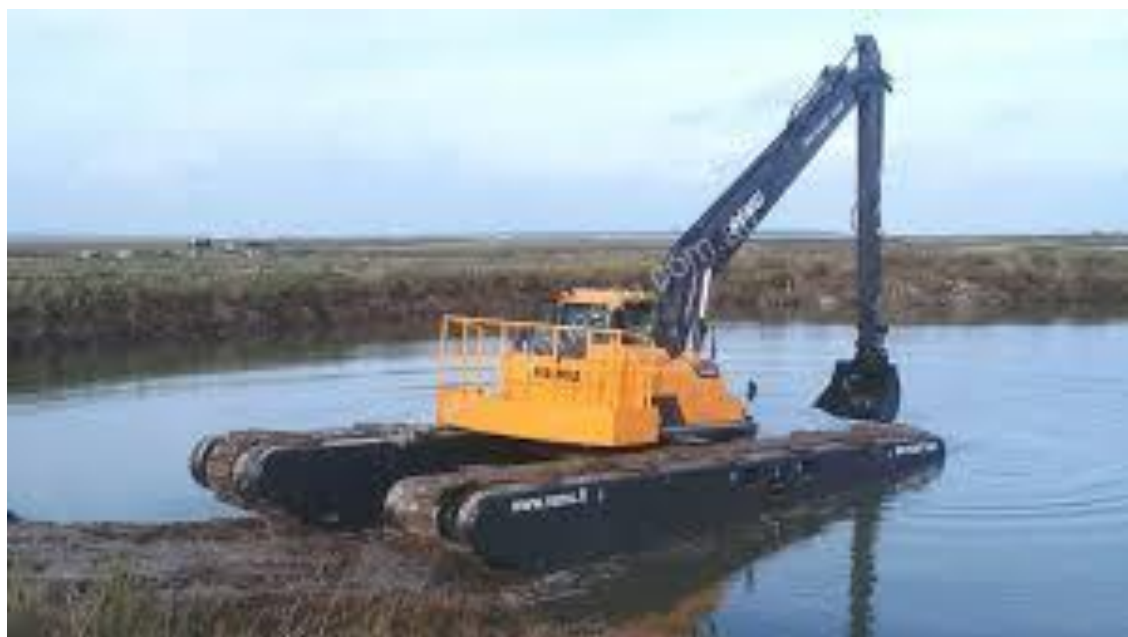
Foto 2: Săparea șanțului pentru traversare Balta Mare și Balta de Mijloc cu excavator clasic (pentru adâncimi mici ale apei)
