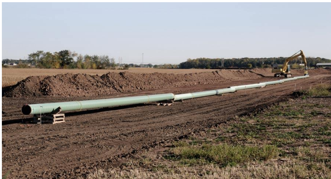
Foto 4: Formarea șirului de țevi
