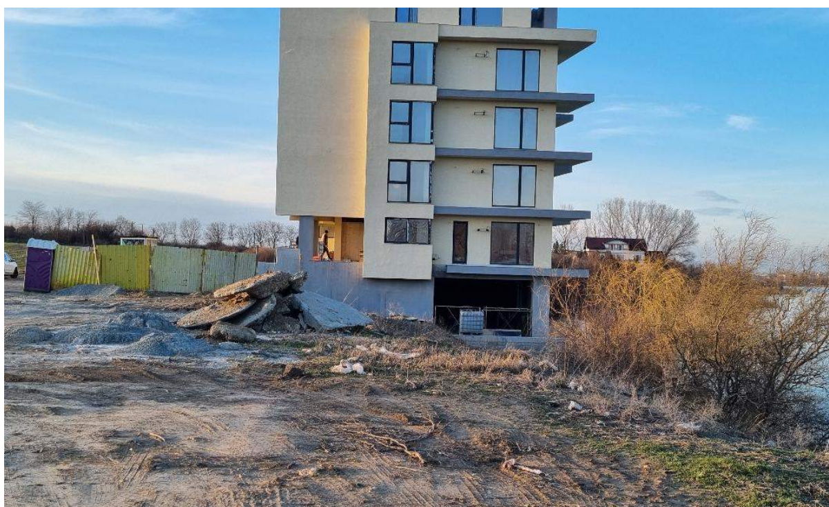
Fig, nr.3 Vecin teren la partea de Nord a terenului studiat (foto realizata in Februarie 2024)
