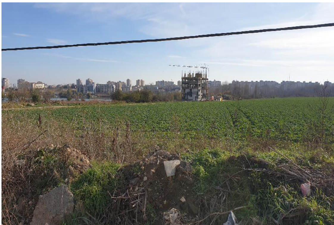
Fig. nr.26 Imobil aflat in constructie pe amplasamentul studiat prin PUZ si teren agricol
