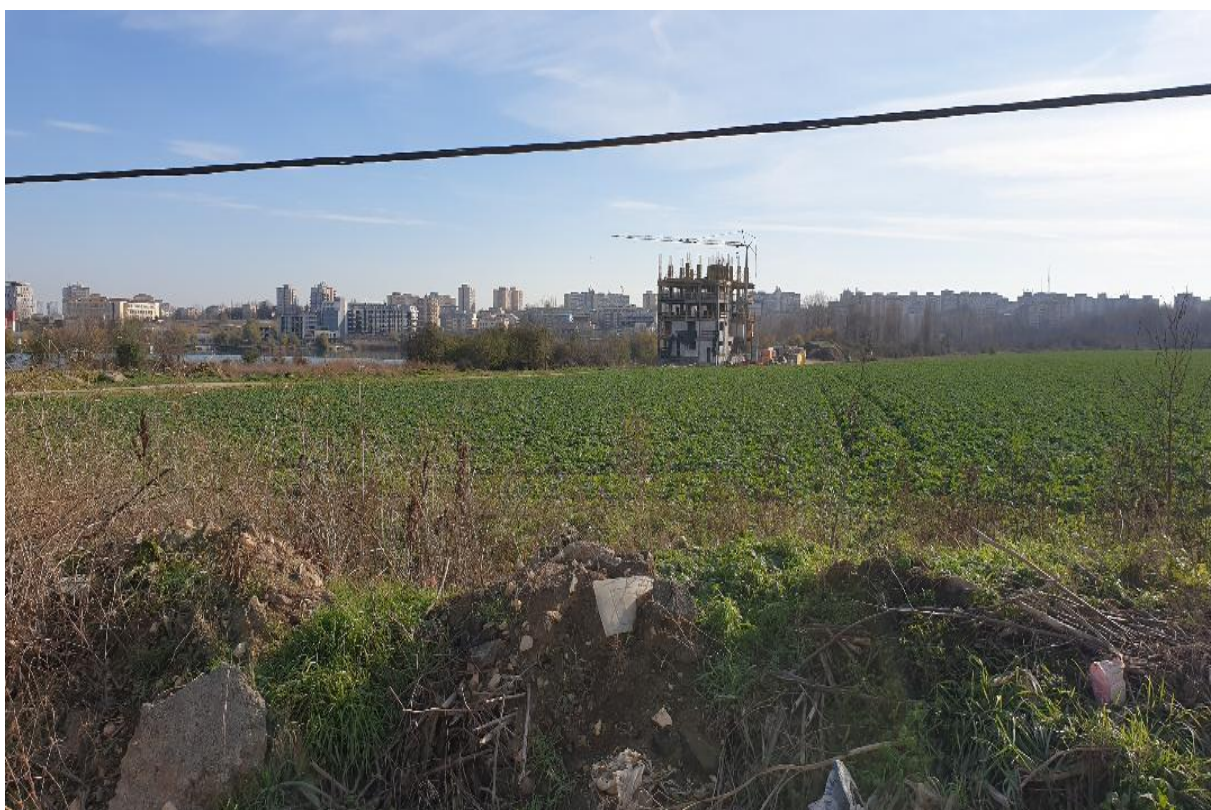
Fig. nr 3 Imobil de locuințe colective S+P+4E în curs de execuție în zona PUZ analizat
