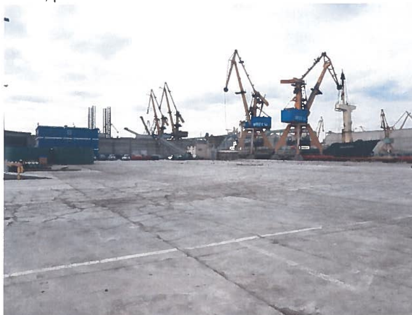
Foto 2: Aspect al amplasamentului
