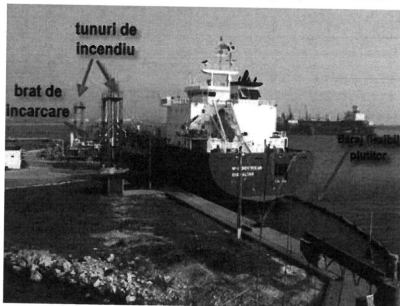
Figura 95 – Navă la dana 9A, cu brațul MLA cuplat și tunurile SKUM
